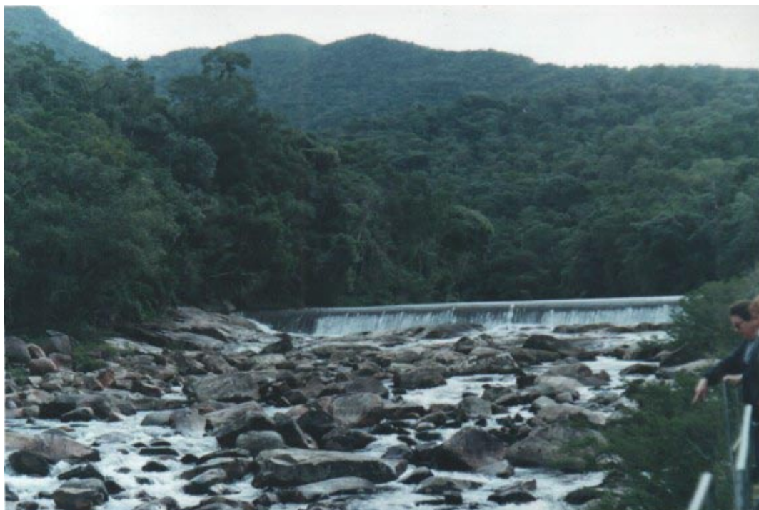
FOTO 08: Represa do Rio Pilões – SAI
