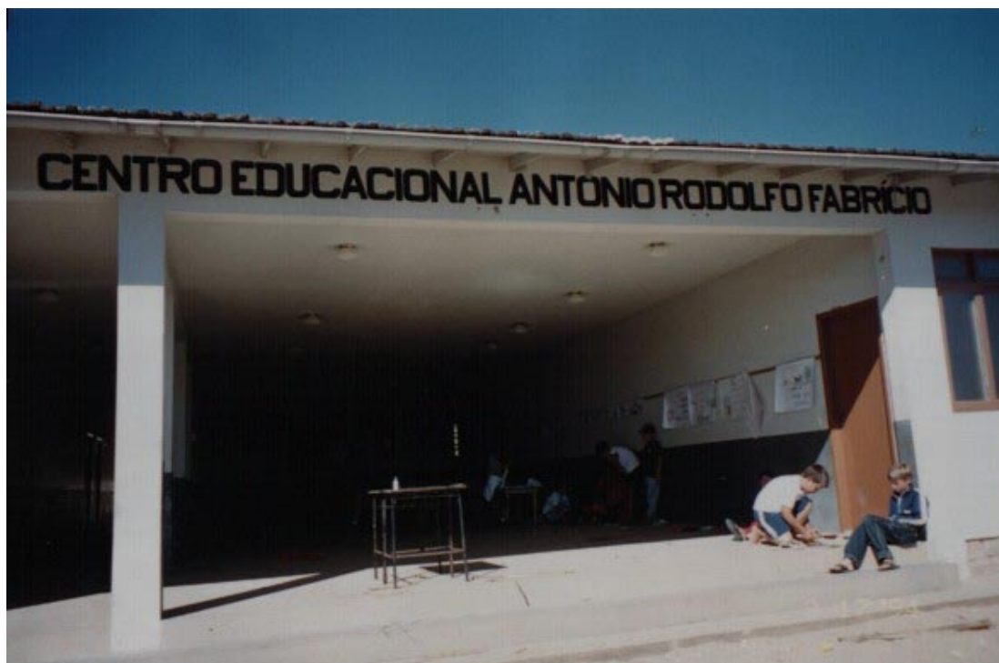
FOTO 01: Vista Frontal da Escola do Fabrício – SAI
