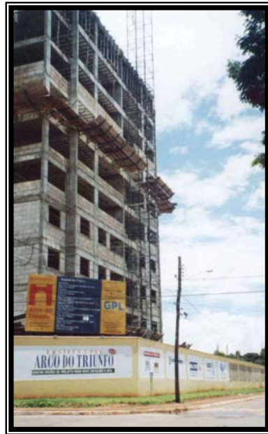
Figura 4.7 – A obra do Estudo de Caso 2
