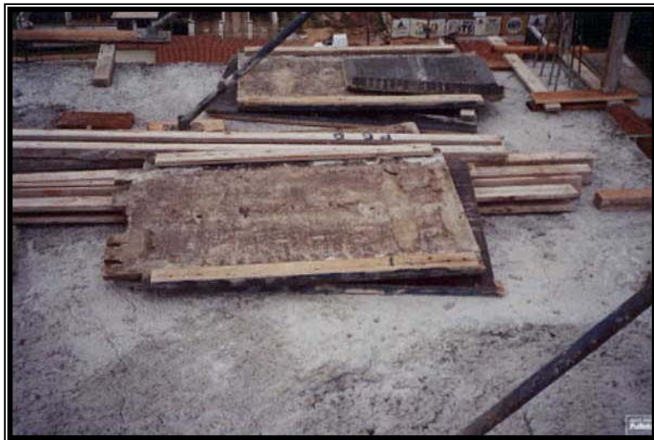
Figura 5.15 – A necessidade de antecipação de inspeção de materiais reutilizáveis
