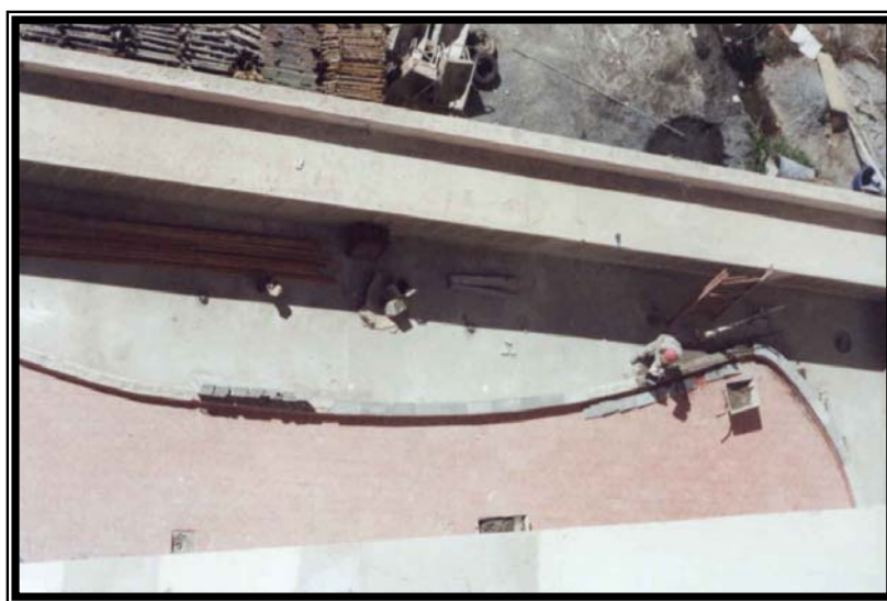
Figura 5.32 – Antecipação de execução do piso externo no pavimento térreo
