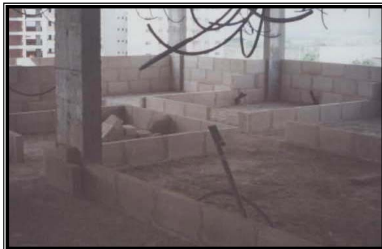
Figura 5.13 – A antecipação de execução das primeiras fiadas da alvenaria da periferia da laje
