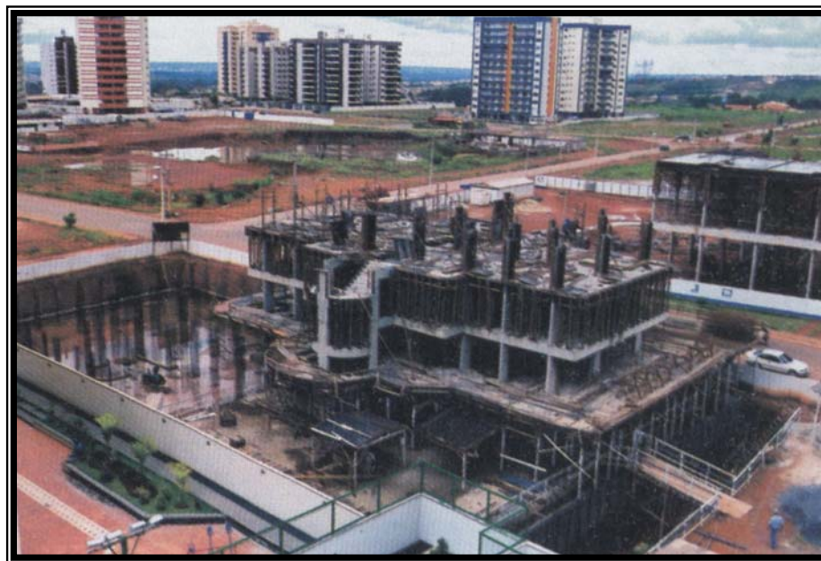
Figura 4.9 – A Obra 7 do Estudo de Caso 3
