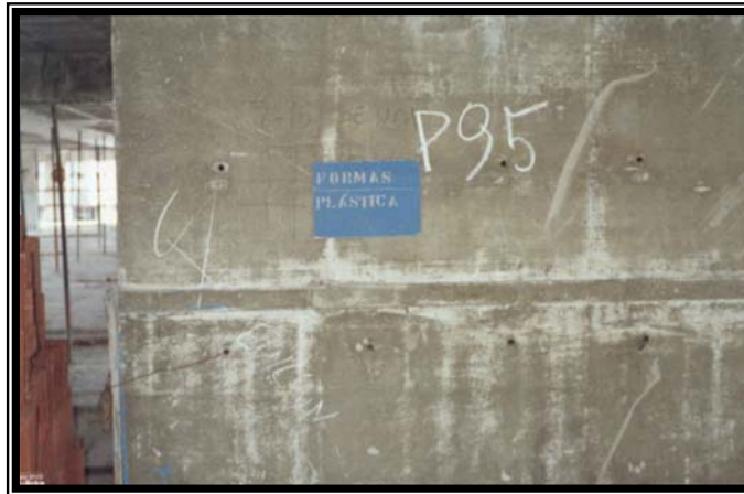
Figura 5.38 - Comunicação visual sobre o local de armazenagem de fôrmas plásticas
