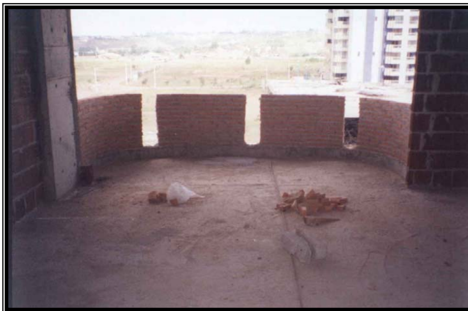
Figura 5.37– Antecipação de segurança do trabalho através da construção da mureta da sacada
