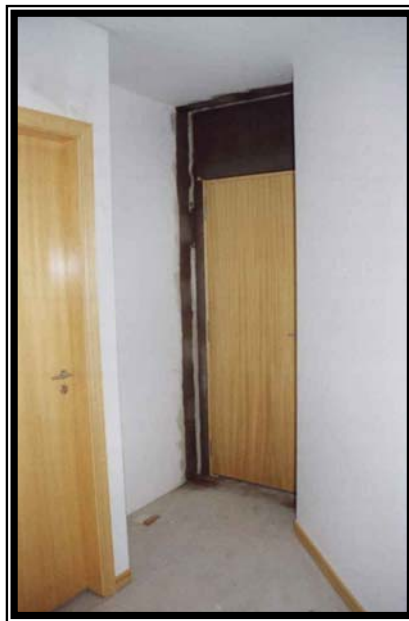
Figura 5.6 – A consequência da negligência com a antecipação de coordenação volumétrica no projeto de localização da porta
