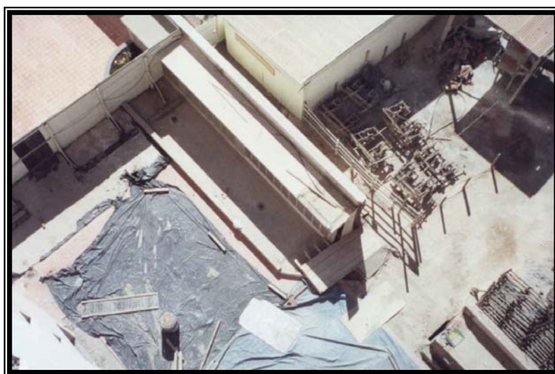
Figura 5.33 – Antecipação de proteção do piso externo do pavimento térreo
