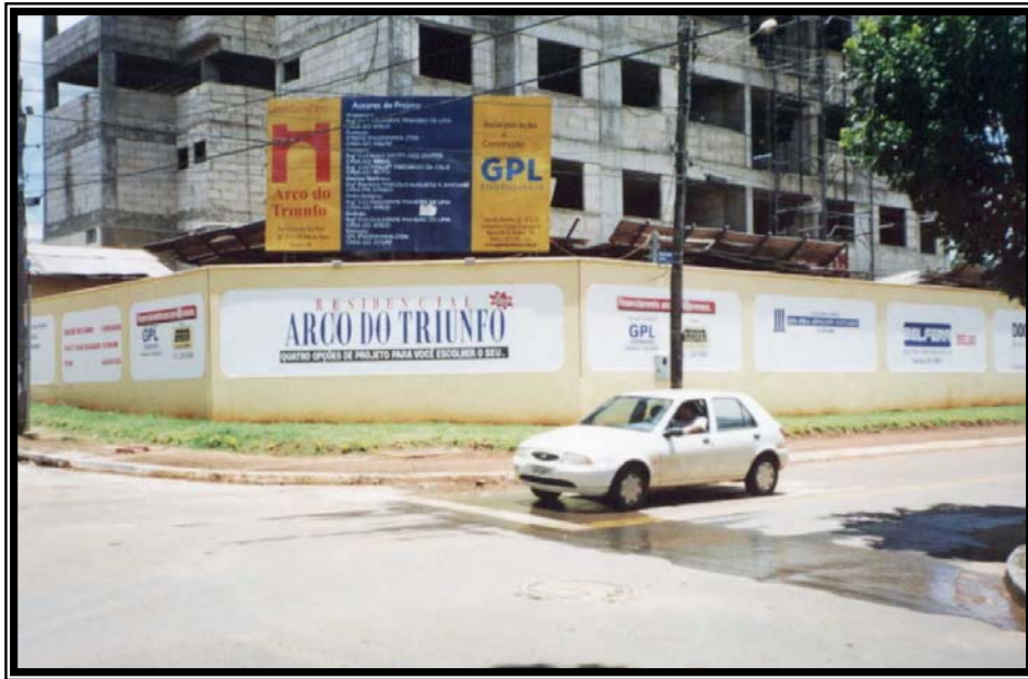
Figura 5.17 – Antecipação de construção do muro da obra
