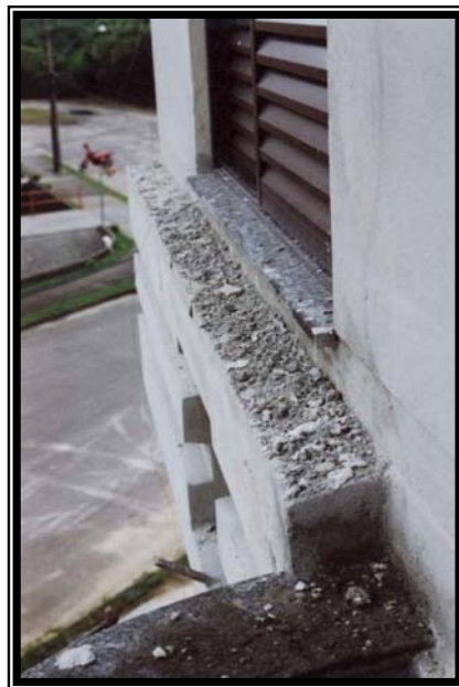
Figura 5.11 – A consequência gerada pela negligência com a antecipação de terminação e limpeza do parapeito da janela
