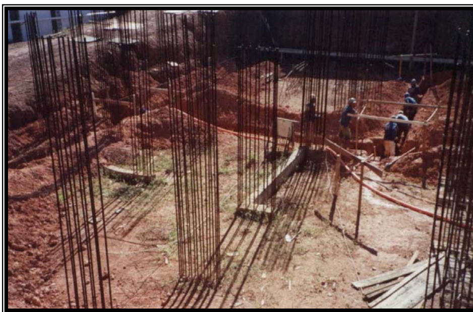
Figura 5.36 – Antecipação técnica de eliminação do transpasse nas armaduras
