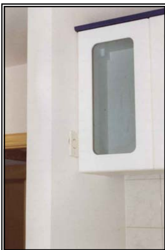
Figura B1 – O problema gerado pela negligência com a antecipação de coordenação entre os projetos elétrico e de acabamento do armário.
