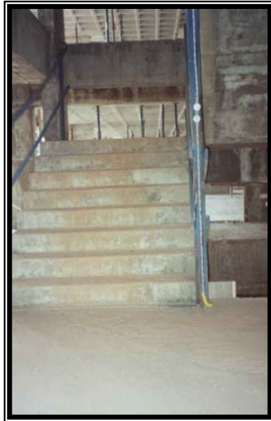
Figura 5.40 – Antecipação de colocação do corrimão da escada como medida de segurança
