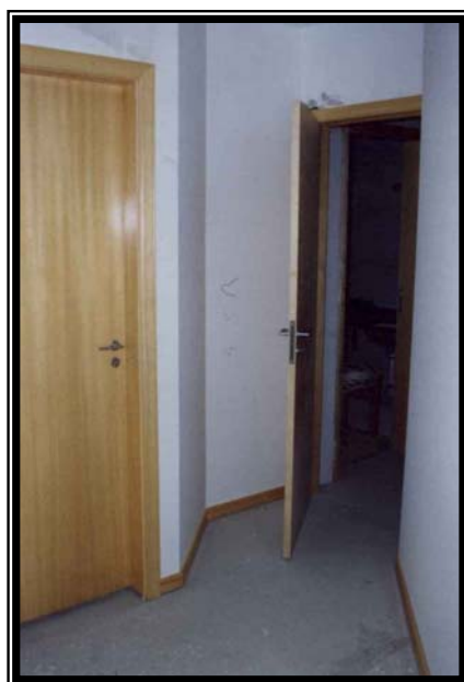
Figura 5.5 – O problema gerado pela negligência com a antecipação de coordenação volumétrica no projeto de abertura de uma porta
