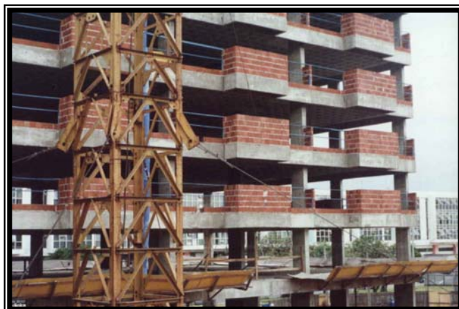
Figura 5.39 – Antecipação na construção de muretas da periferia das lajes como medida de segurança
