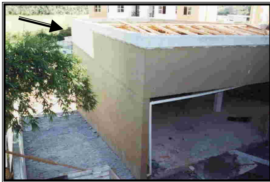
Figura 5.10 – O atraso na execução da pintura externa em função da negligência com a antecipação de nivelamento
