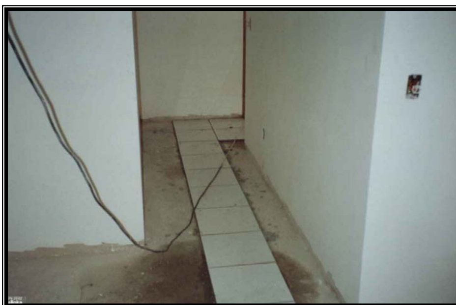
Figura 5.31 – Detalhes da antecipação de paginação de piso com revestimento cerâmico
