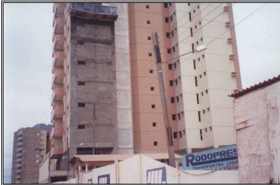
Figura 5.26 – Antecipação de execução de serviços na fachada
