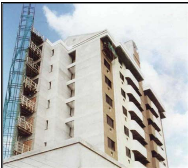
Figura B4 – O problema do acesso à fachada.
