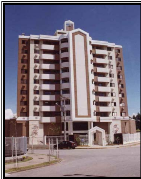
Figura 4.5 – A obra do Estudo de Caso 1
