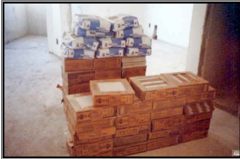
Figura 5.24 – Antecipação de transporte de materiais ao posto de trabalho
