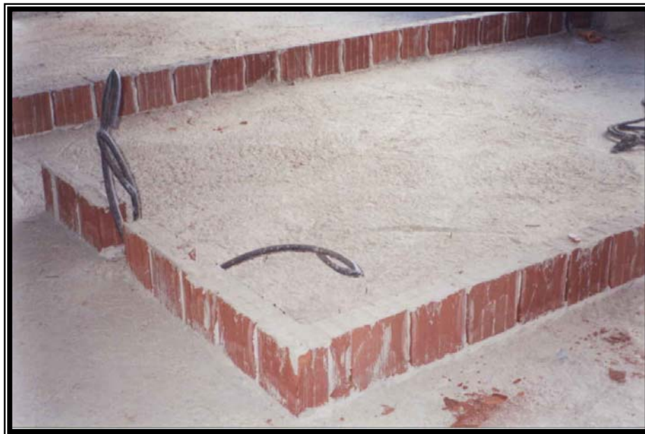
Figura 5.35 – Antecipação técnica de reforço na base da alvenaria
