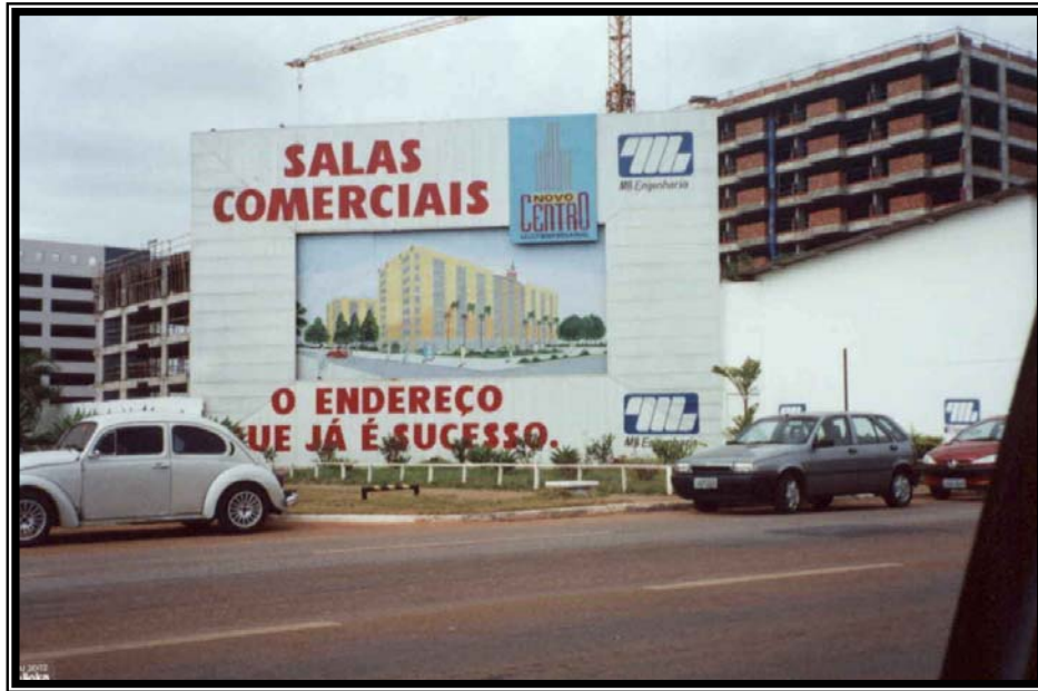
Figura 4.10 – A Obra 8 do Estudo de Caso 3
