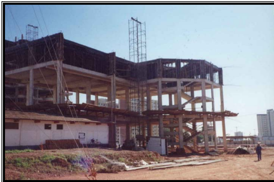
Figura 4.8 – A Obra 3 do Estudo de Caso 3
