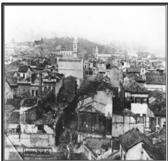
Fig.2 - Centro do Rio de Janeiro, início das obras de demolição, 1903. Arquivo Geral da Cidade do Rio de Janeiro
