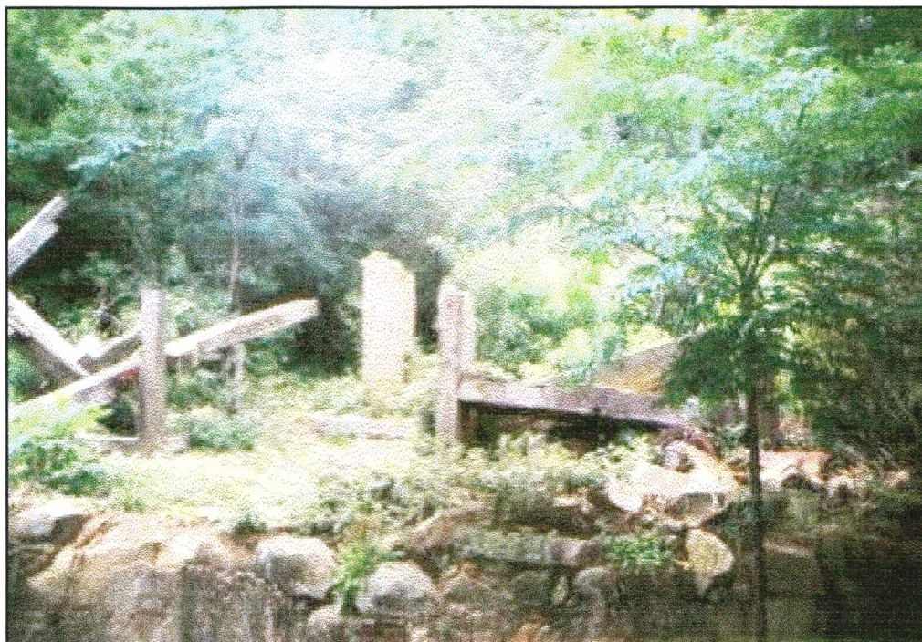
FIGURA 10: RUÍNAS DE ANTIGO ENGENHO DESATIVADO.
