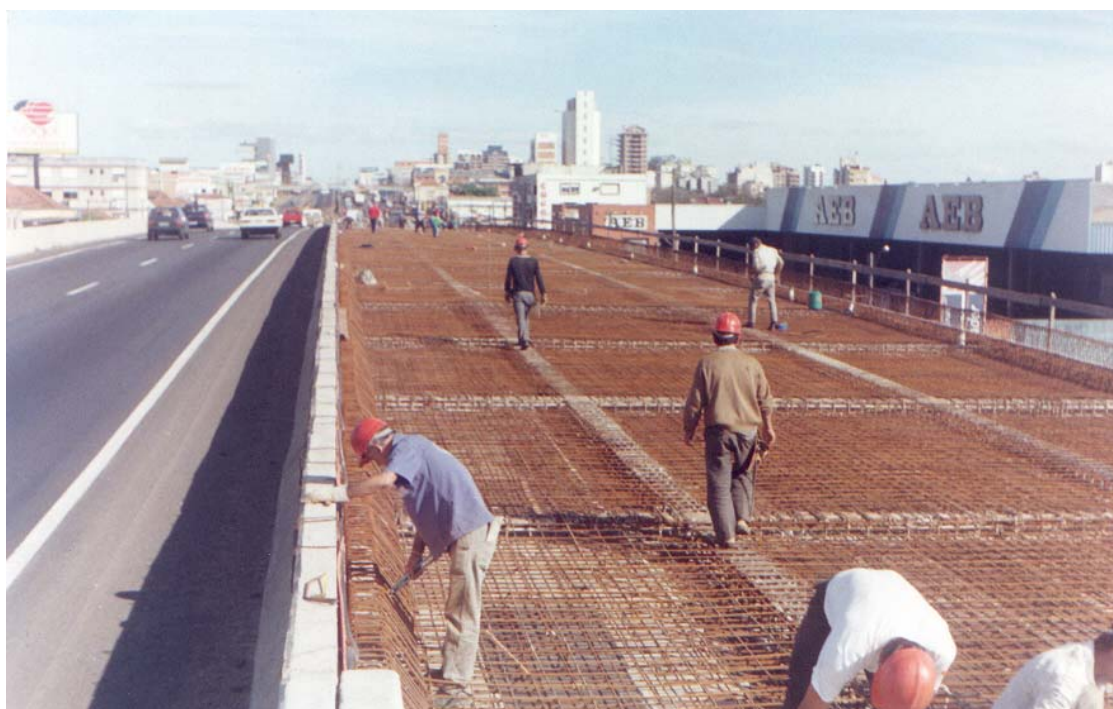
FIGURA 25 - Montagem da laje superior em M2.
