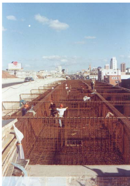
FIGURA 24 - Vigas e laje inferior em M2.
