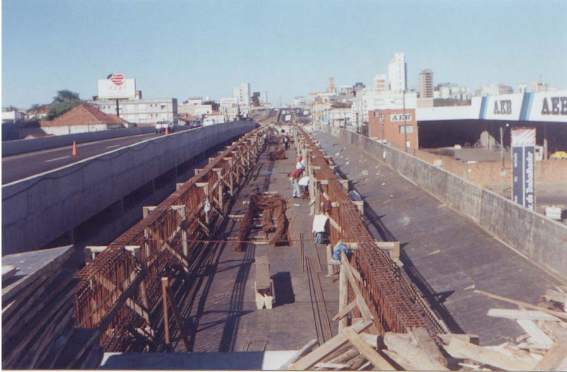
FIGURA 21 - Montagem de vigas em M2.
