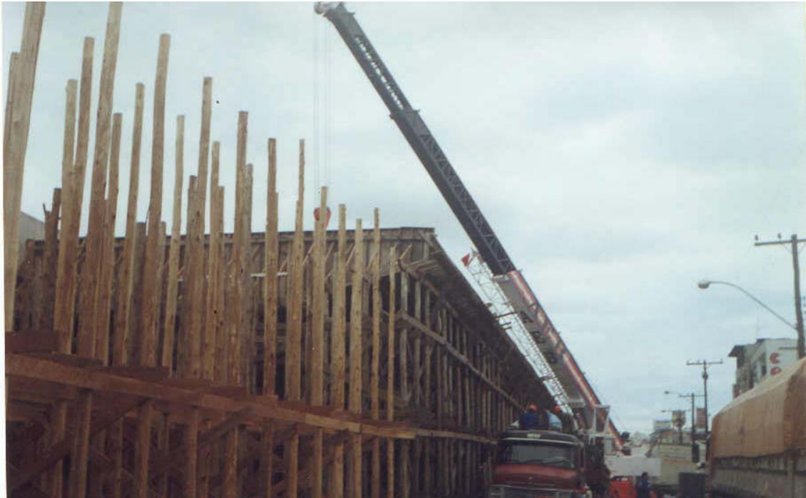
FIGURA 22 - Transporte mecanizado do aço, verticalmente e horizontalmente (JIT)
