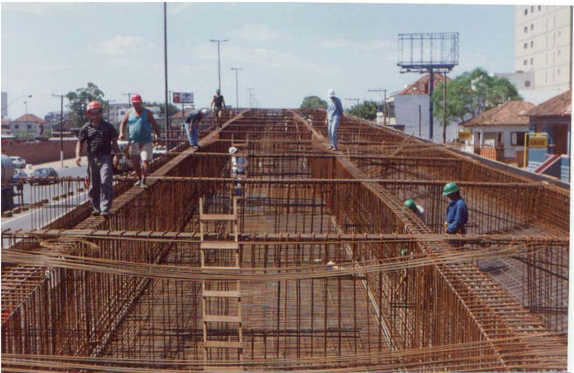
FIGURA 20 - Execução da ferragem em M1.
