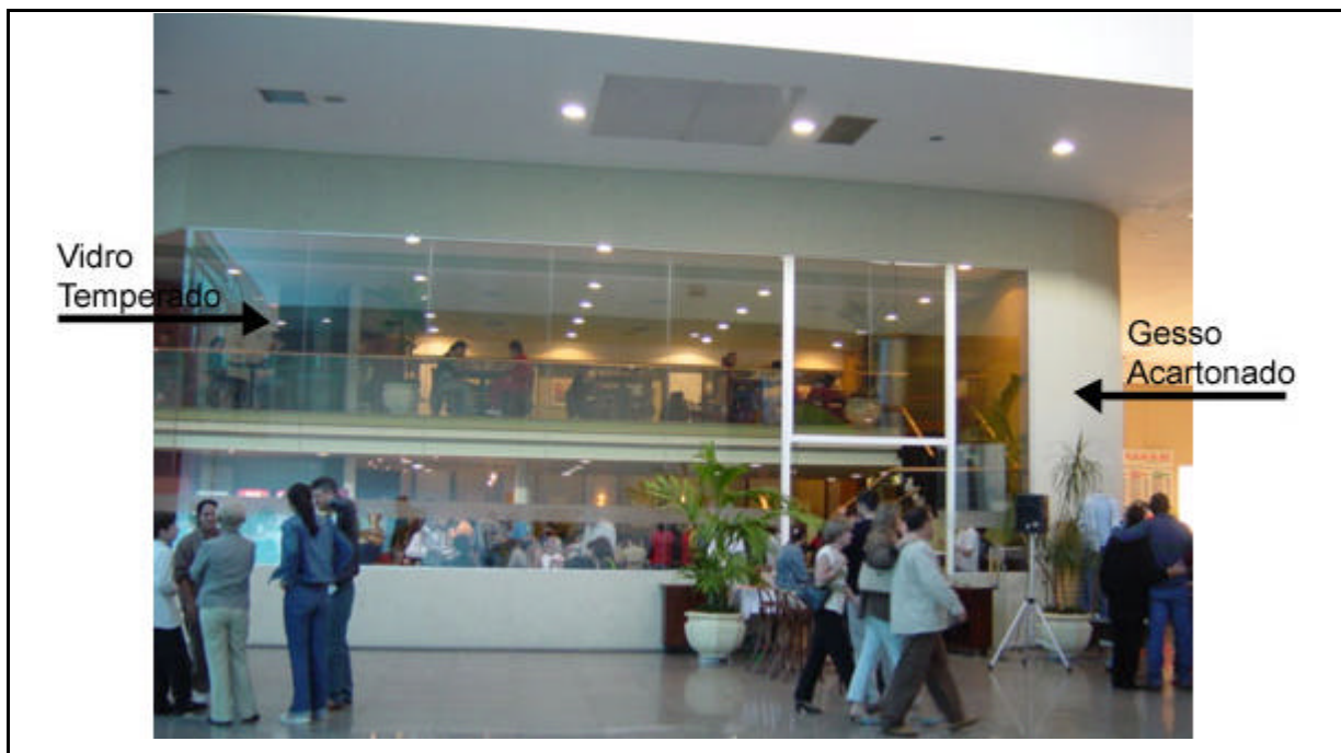
Figura 19 - Vista Parcial do restaurante com as adaptações
