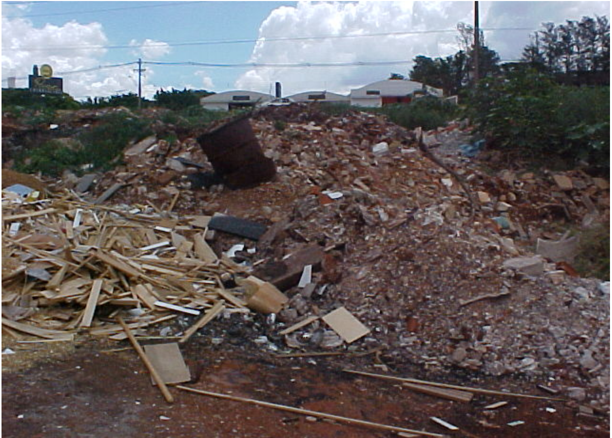
Foto 05: Deposição de RCD na malha urbana do município de Maringa.
