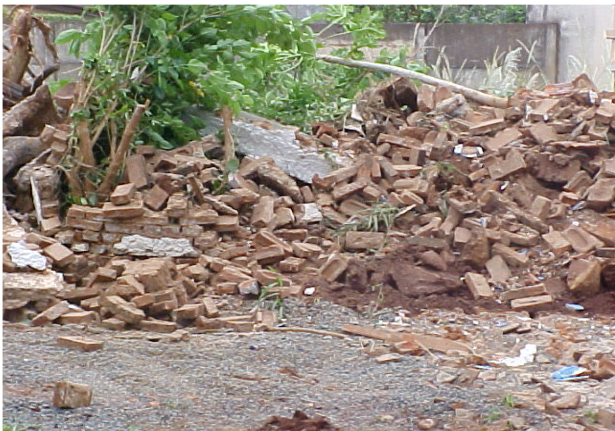
Foto 02 : Deposição de RCD na malha urbana do município de Maringa.
