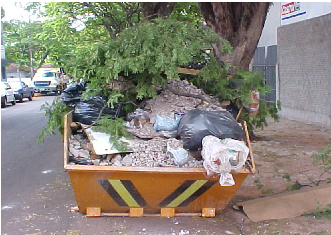
Foto 08 : Container no perímetro urbanos com RCD e presença de resíduos resultantes de podas e não oriundos da construção atendida pela empresa coletora.
