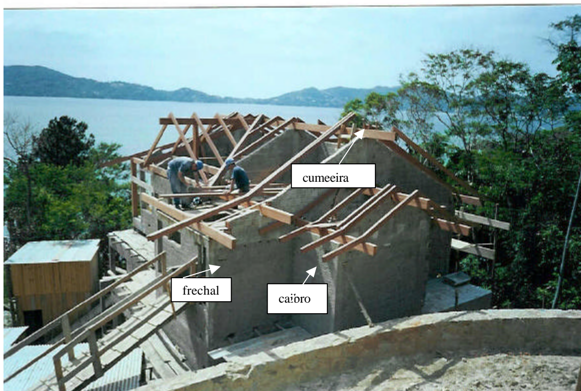
Figura 6 – Local do madeiramento de cobertura estudado
