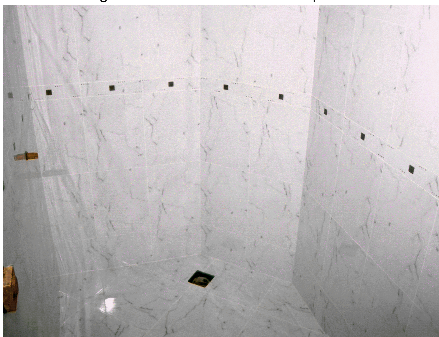
Figura 38 – O banheiro coletivo pronto
