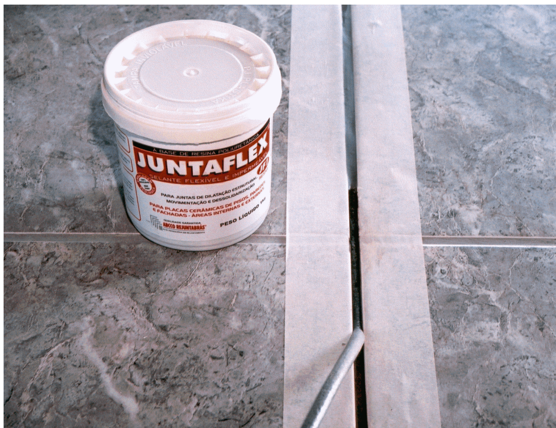
Figura 36 – Execução da junta de movimentação
