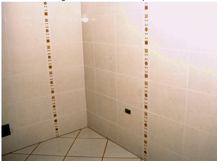
Figura 37 – A lavanderia pronta
