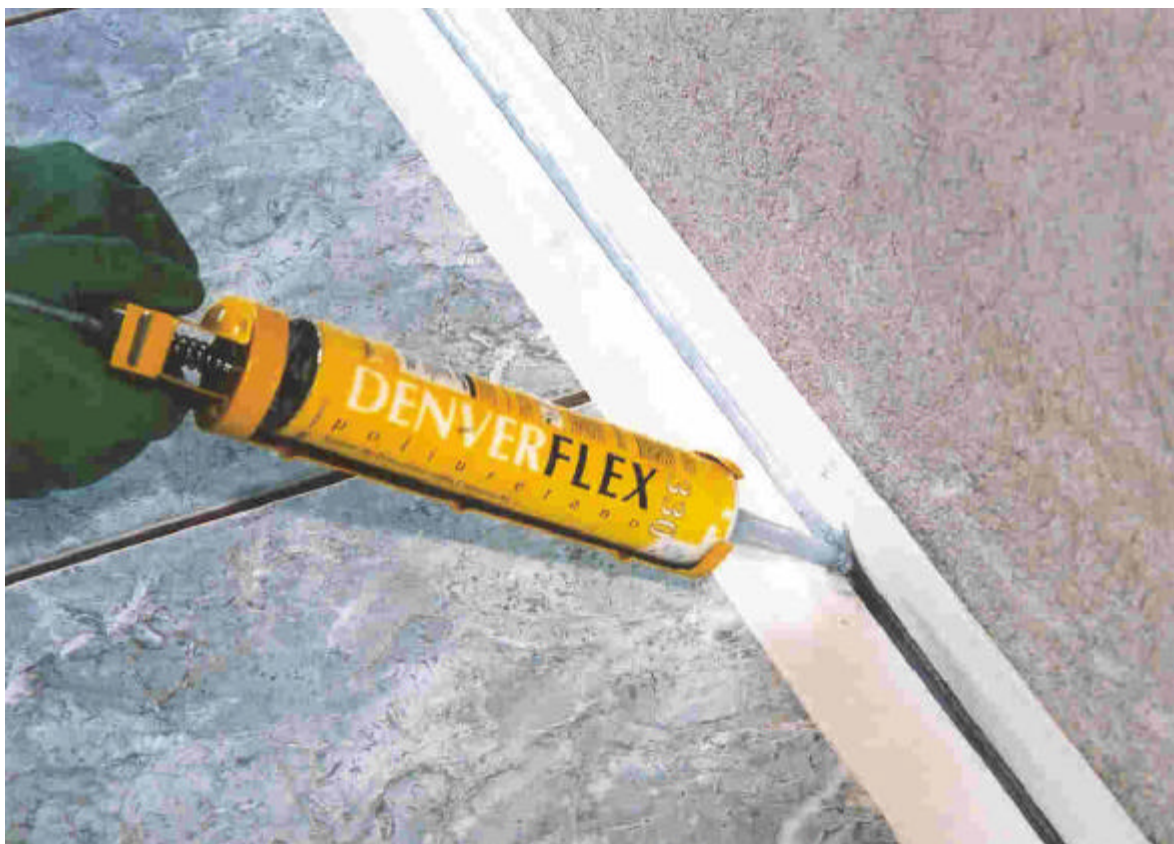
Figura 35 – Execução da junta de dessolidarização
