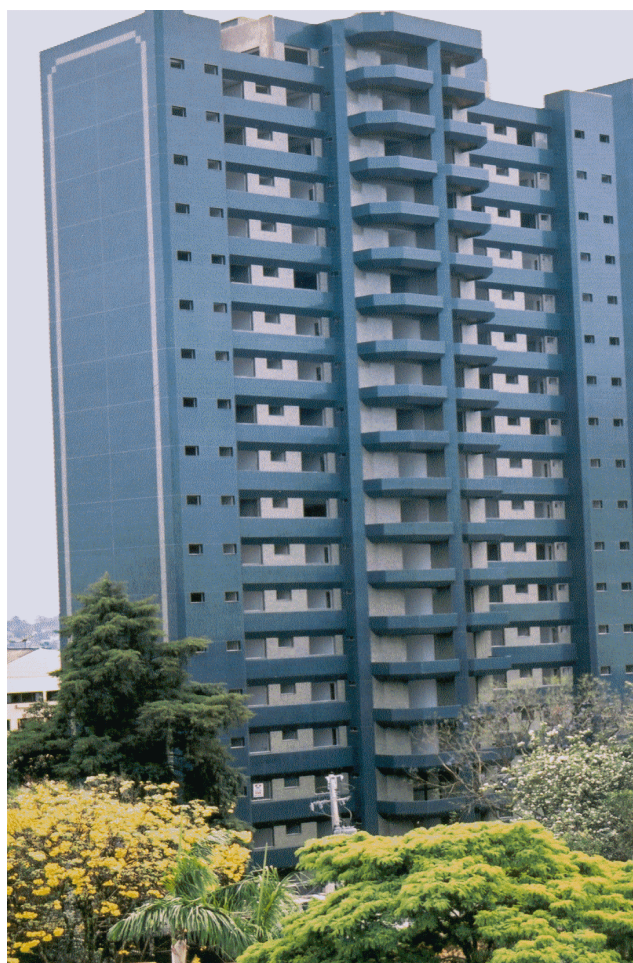
Figura 15 – O Edifício Le Monde, em fase de acabamentos
