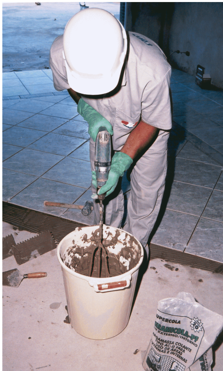
Figura 32 – Preparação mecânica da pasta de argamassa colante
