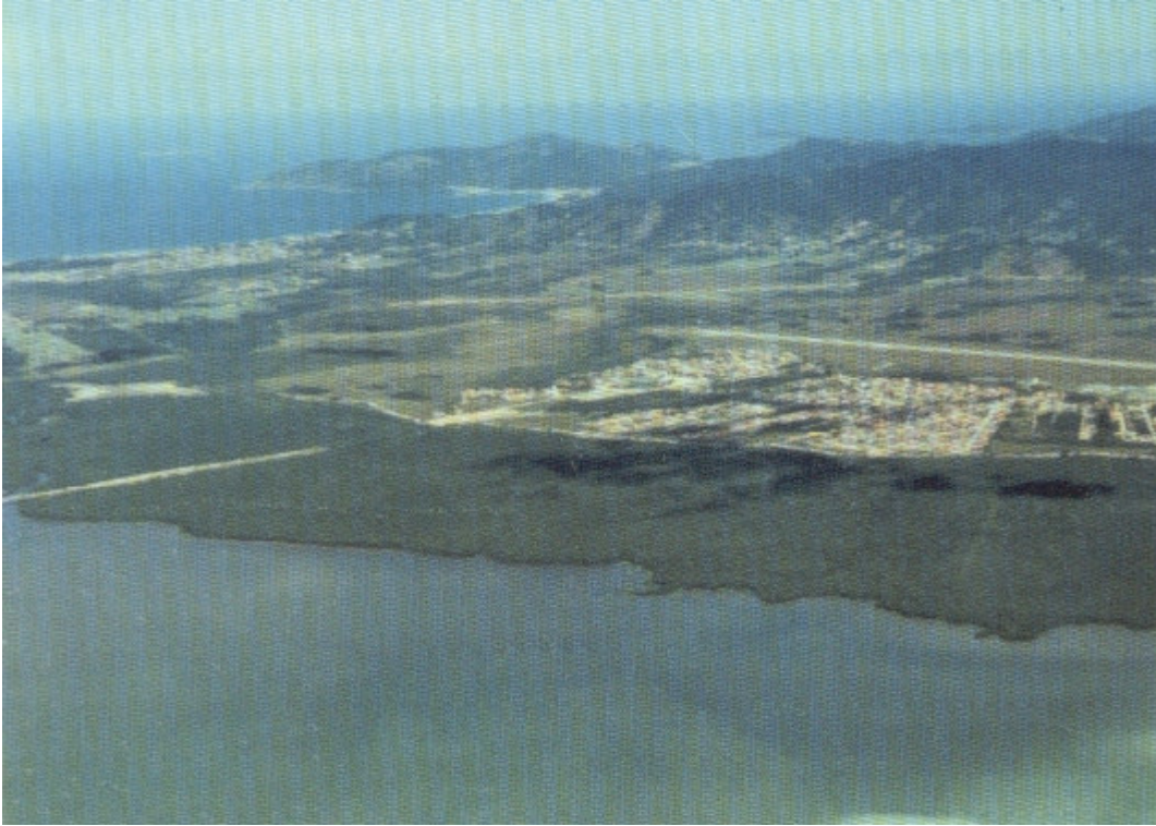
Figura 1 – Vista geral da REMP
