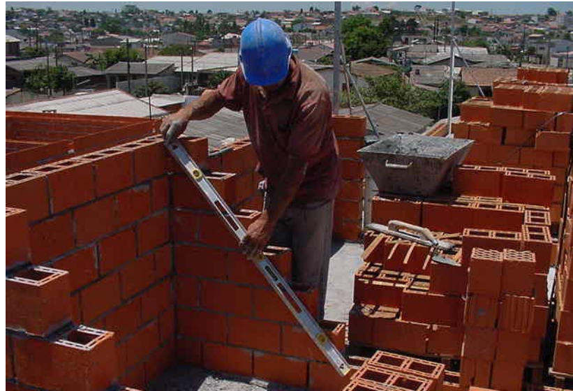
Figura 39: Execução da alvenaria, utilização da régua prumo e nível na conferência da planicidade da parede – obra AECE
