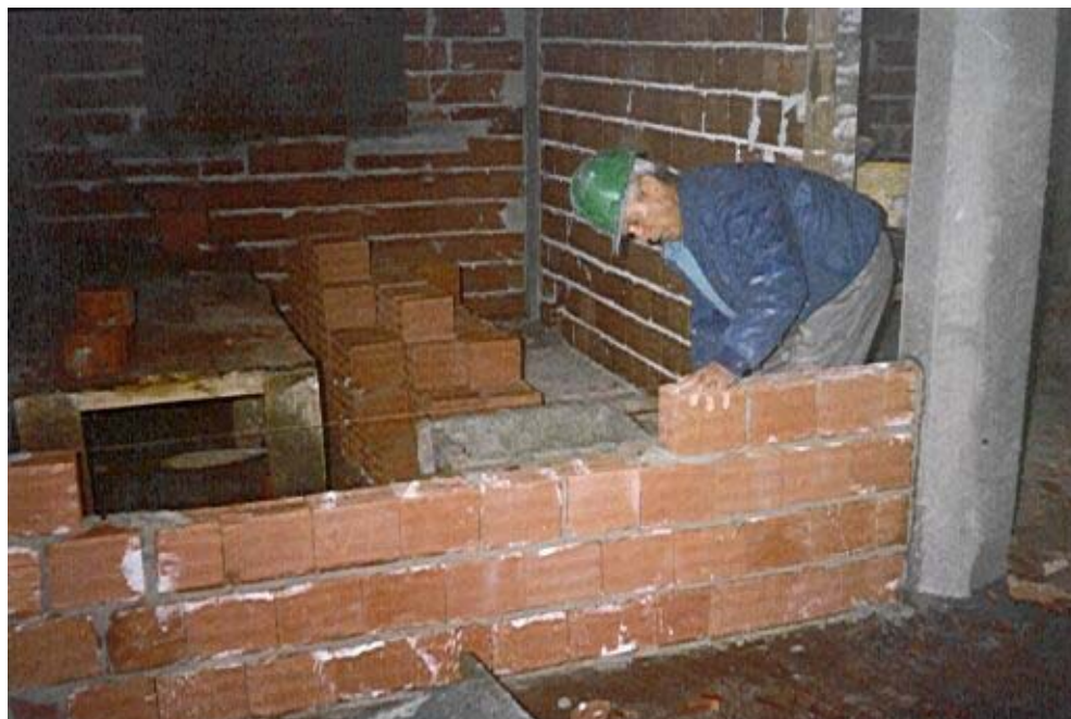
Figura 40: Execução da alvenaria – obra CACE
