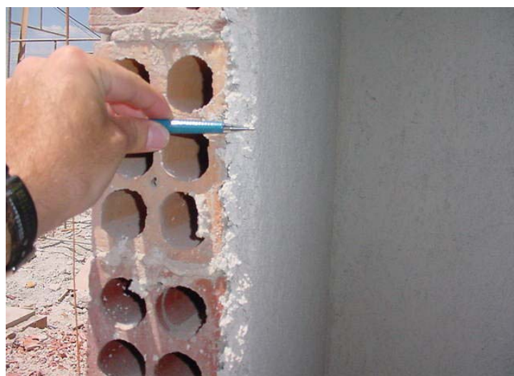
Figura 31: Espessura do revestimento interno para obra CACE
