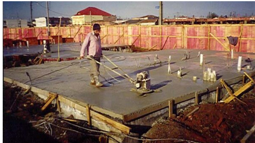
Figura 14: Regularização do piso zero
