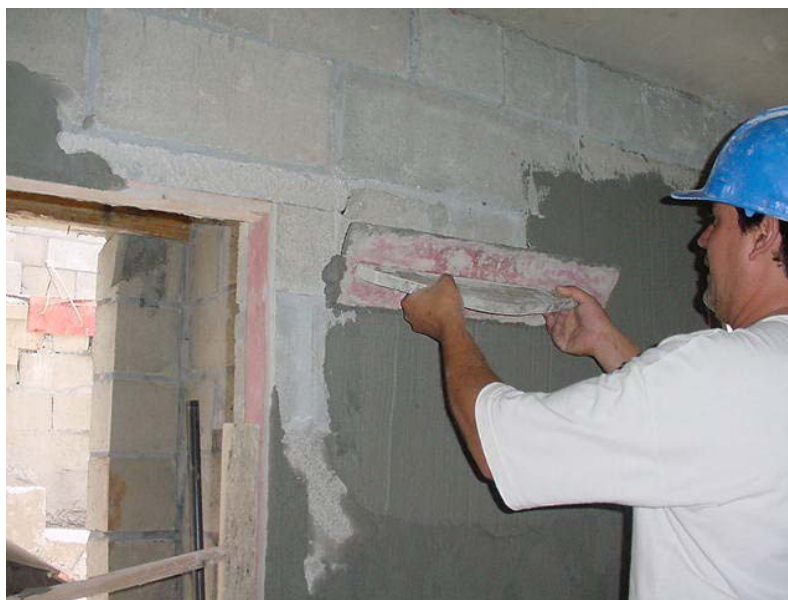
Figura 29: Execução do revestimento interno obra AECO
