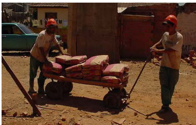
Figura 48: Transporte da argamassa industrializa pelos serventes
