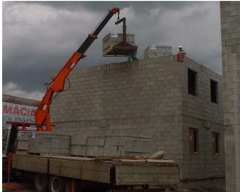
Figura 23: Colocação dos palets sobre a laje
