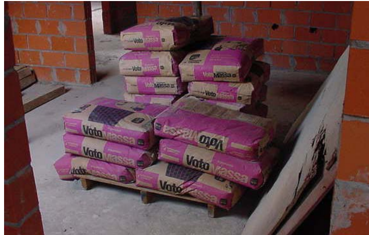
Figura 42: Estocagem de argamassa nos apartamento para execução do revestimento interno para as obras em alvenaria estrutural
