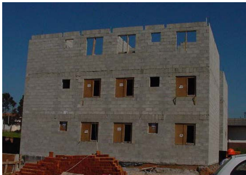
Figura 6: Edifício em alvenaria estrutura com blocos de concreto de 14x19x39 cm
