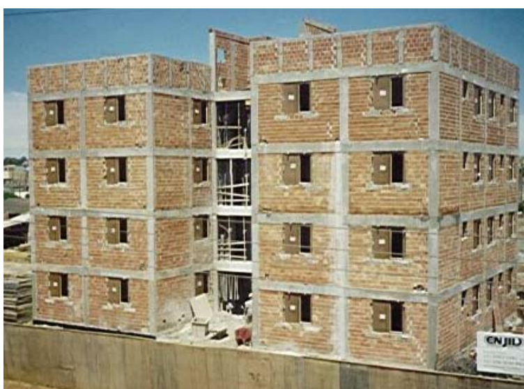
Figura 7: Edifício em concreto armado
