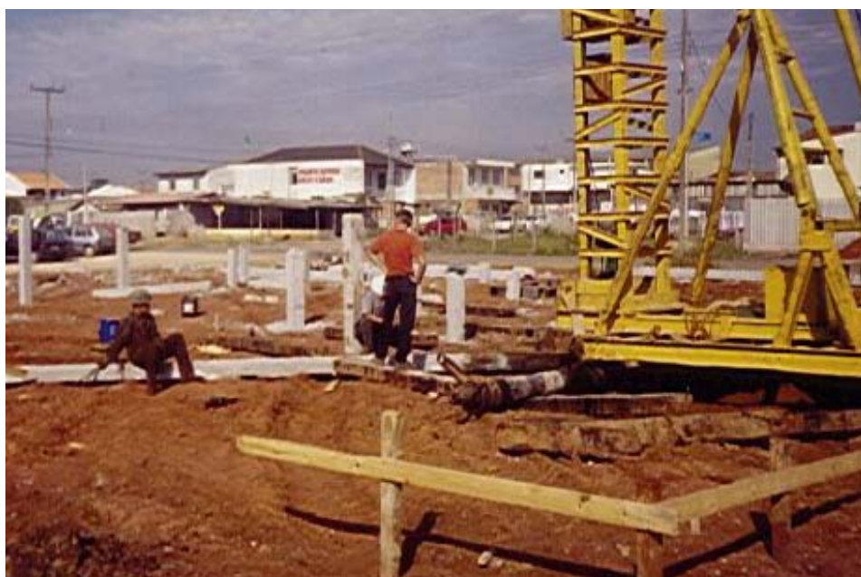
Figura 11: Cravação das estacas pré-moldadas na obra AECE
