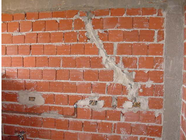
Figura 25: Alvenaria obra CACE
