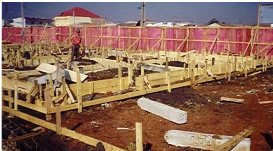
Figura 35: Montagem das formas do baldrame
