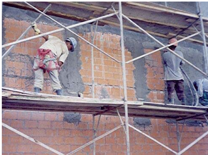
Figura 33: Execução do revestimento externo com argamassa projetada para obra AECE
