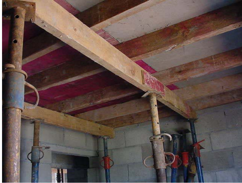
Figura 37: Forma da laje maciça para obra AECO
