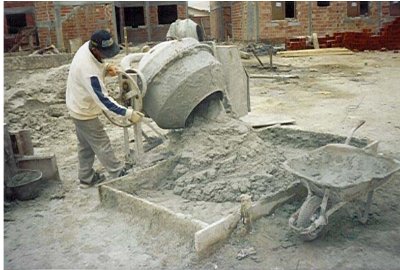
Figura 30: Confeção da argamassa com obra CACE
