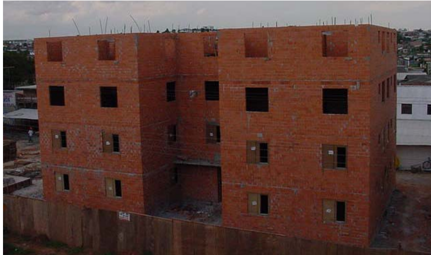
Figura 5: Edifício em alvenaria estrutural com blocos cerâmicos de 12x14x25 cm
