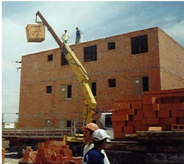
Figura 46: Colocação dos palets sobre o pavimento em execução
