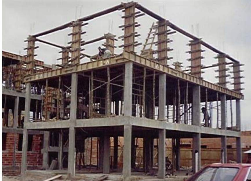
Figura 18: Execução das formas dos pilares
