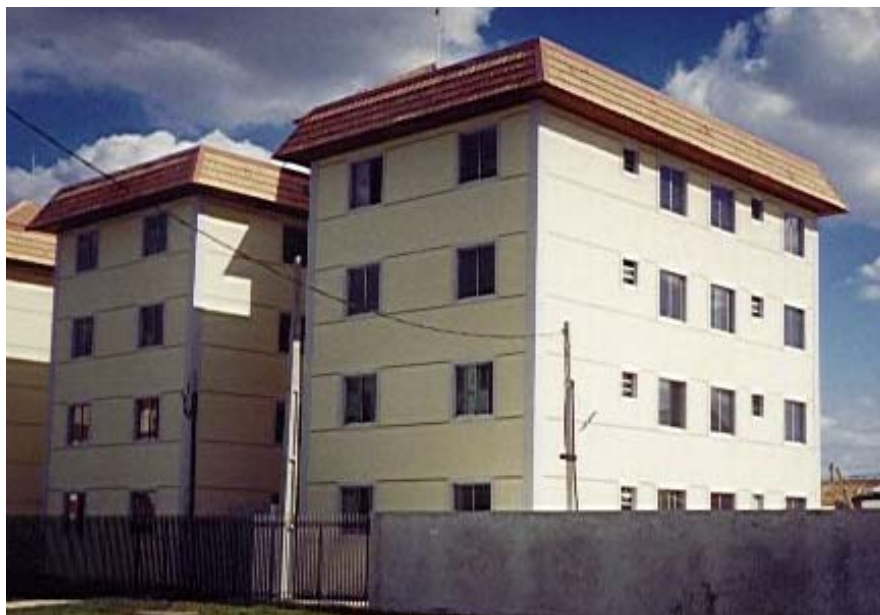
Figura 4: Residencial Ipê – Obra concluída em concreto armado com vedação em blocos cerâmicos
