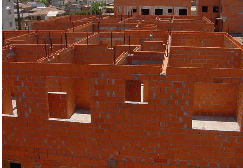
Figura 22: Alvenaria obra AECE
