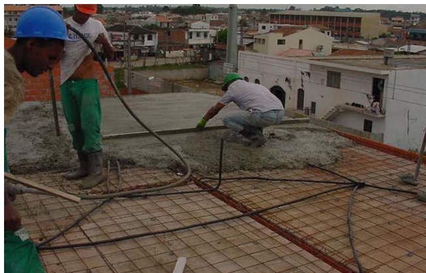
Figura 17: Preenchimento das canaletas da última fiada com concreto
