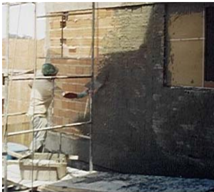
Figura 45: Execução do chapisco para obra CACE
