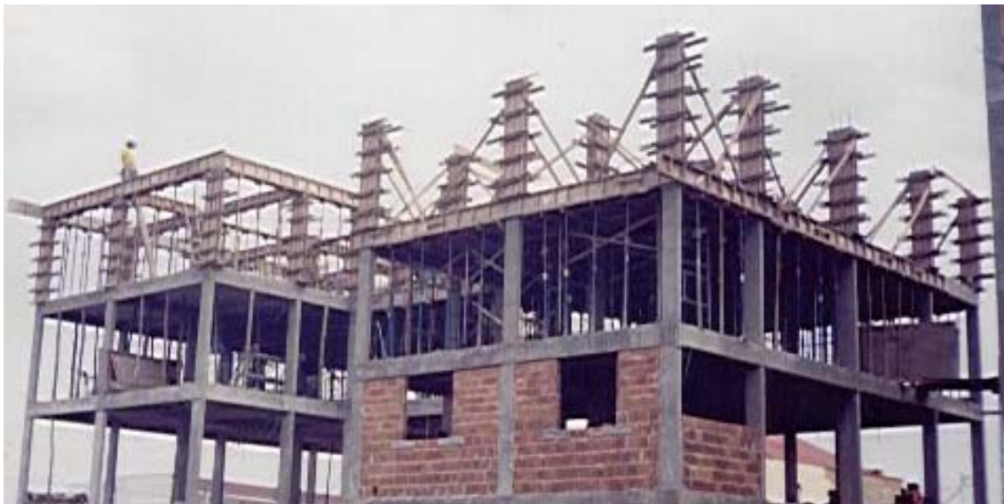
Figura 38: Forma da laje, vigas e pilar para obra CACE
