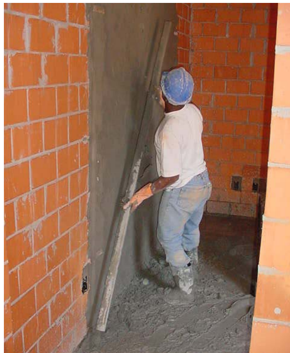
Figura 41: Execução do revestimento interno – obra AECE
