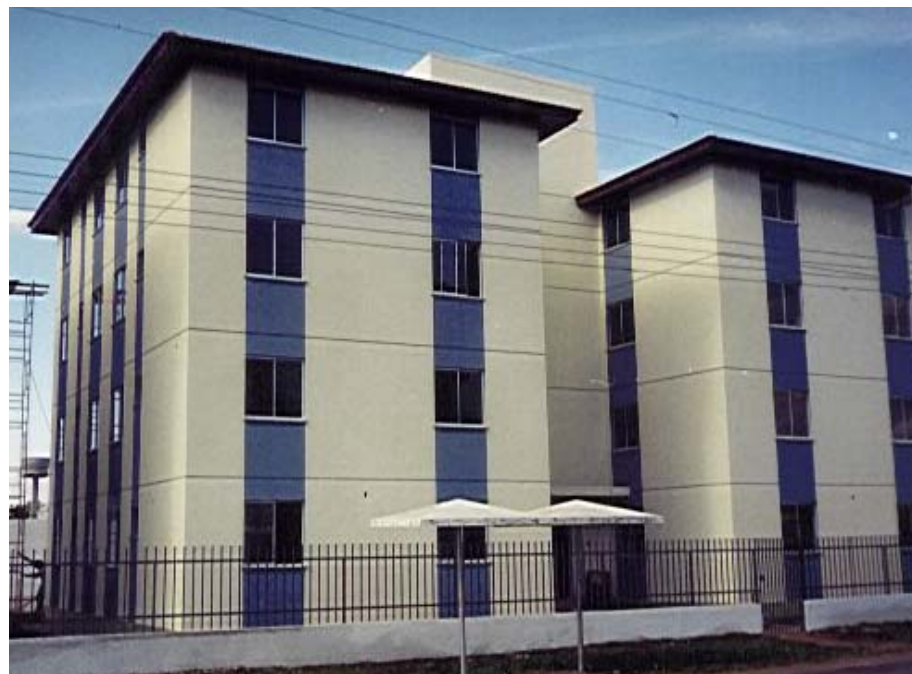
Figura 2: Residencial Perugia – Obra concluída em alvenaria estrutural em blocos de concreto
