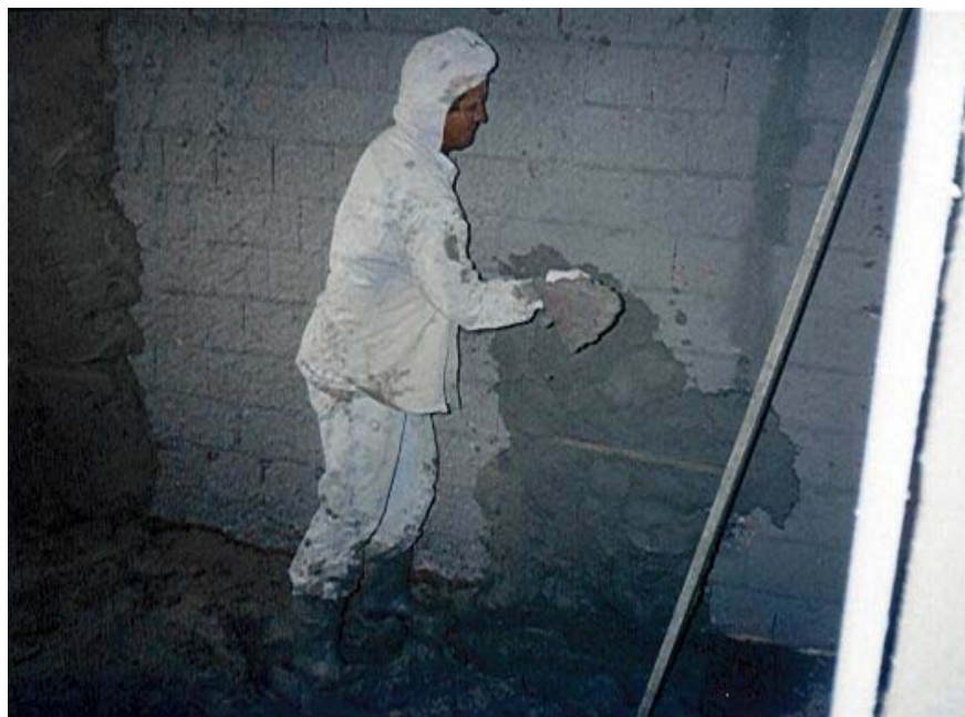
Figura 43: Execução do revestimento interno na obra CACE.
