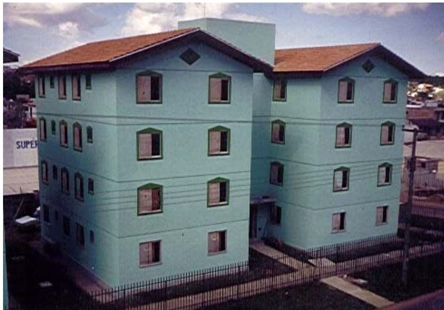
Figura 1: Residencial Nápoli – Obra concluída em alvenaria estrutural em blocos cerâmicos
