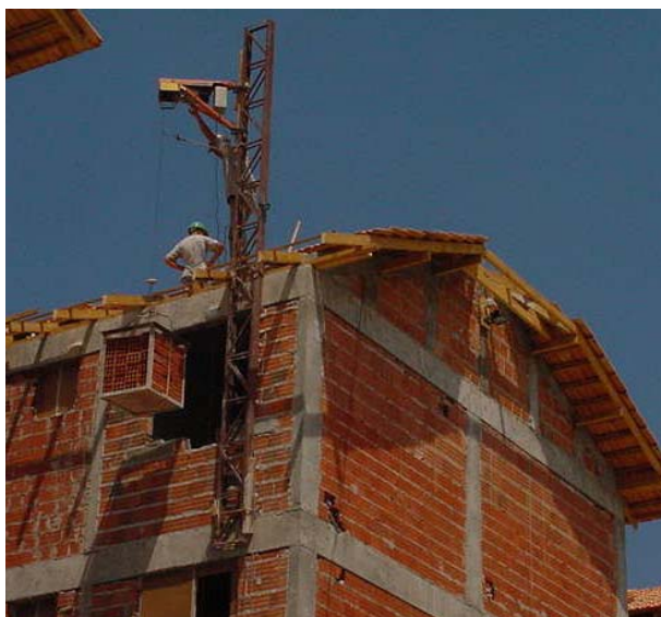
Figura 26: Transporte dos blocos cerâmicos pelo guincho de coluna
