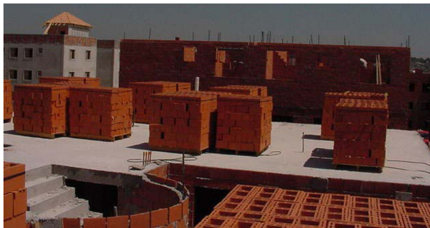
Figura 47: Palets sobre o pavimento em execução
