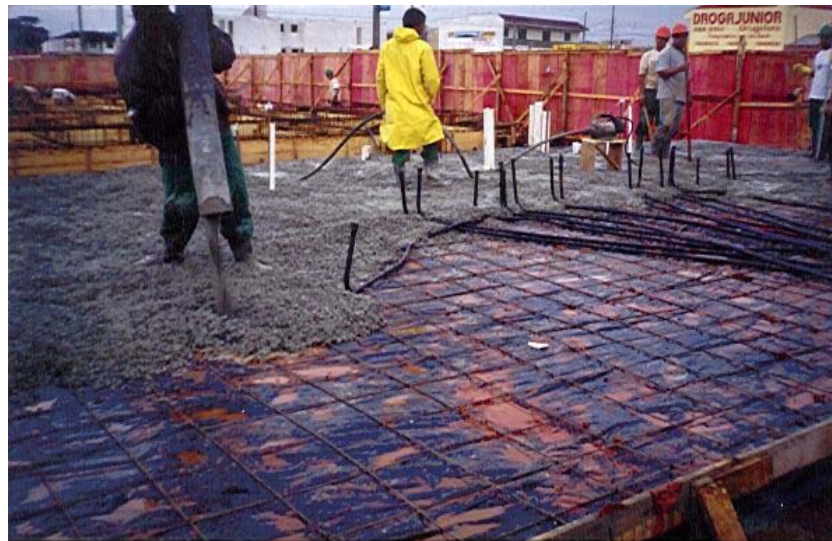
Figura 36: Lona preta sob o piso para evitar umidade
