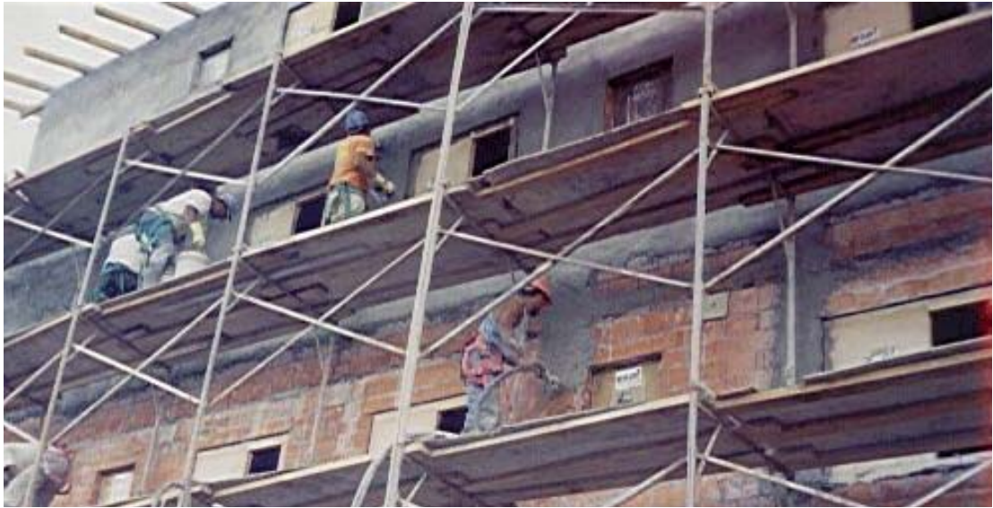
Figura 44: Execução do revestimento externo com argamassa projetada para obra AECE
