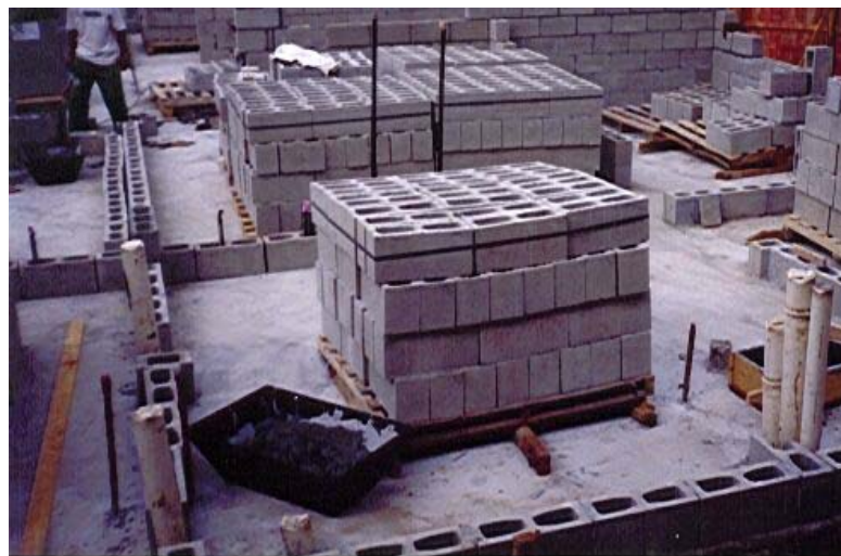
Figura 24: Disposição dos palets na laje
