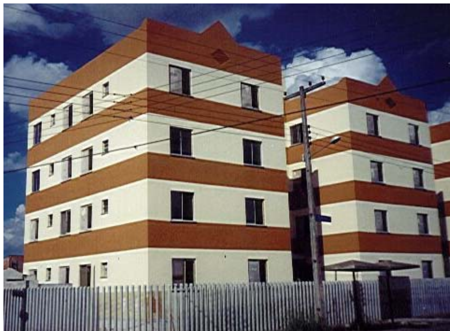
Figura 2: Residencial Veneza – Obra concluída em alvenaria estrutural em blocos cerâmicos
