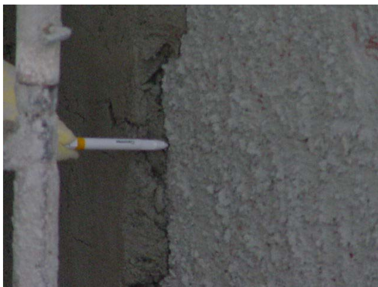
Figura 34: Espessura do revestimento externo
