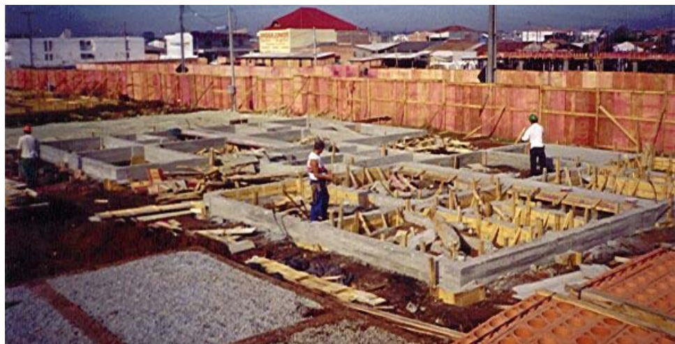
Figura 12: Baldrame em execução - obra AECE
