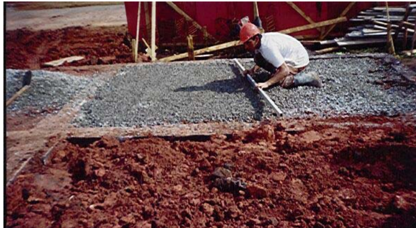
Figura 13: Execução do lastro de brita sobre o solo compactado
