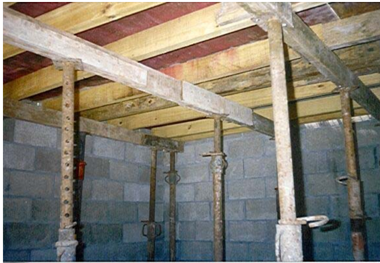
Figura 15: Formas para laje maciça moldada in loco
