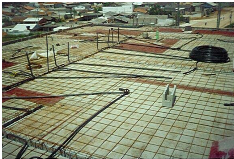
Figura 16: Formas para laje maciça moldada in loco
