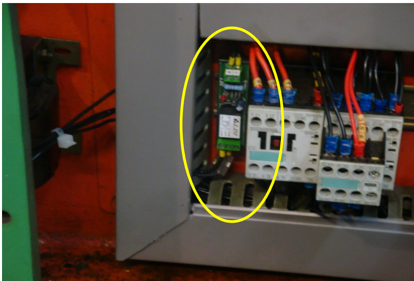
Figura 4.13 – Relé usado para aquisição de sinal de produção.
