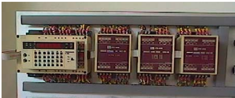
FIGURA 4.4 - PAINEL PLC E MÓDULOS DE EXPANSÃO
