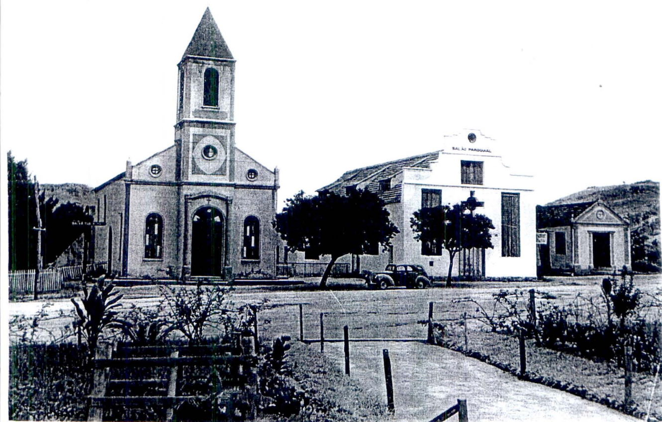
Antiga igrejinha da Trindade, Salão Paroquial inacabado (o telhado tinha mansardas) e Casa do Divino. À esquerda da foto percebe-se a cruz Salva tua alma e ao centro, as duas árvores (pés de legustrum ) cortadas há poucos anos. A praça ainda era um jardim e a rua não tinha calçamento. O carro era o perfect do Padre Pauli. (Foto: cerca de 1957, acervo Paulo Ferreira).
