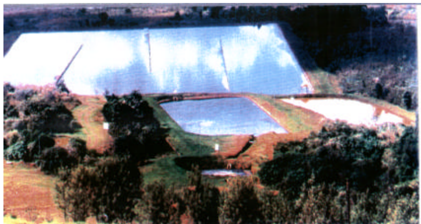
Figura nº.20. Estação de tratamento de líquidos percolados no aterro sanitário da Cachimba.
