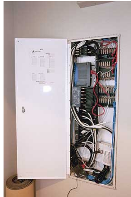
Figura 6 - Caixa com fibras ópticas e cabos coaxiais: centro de comando da rede residencial
