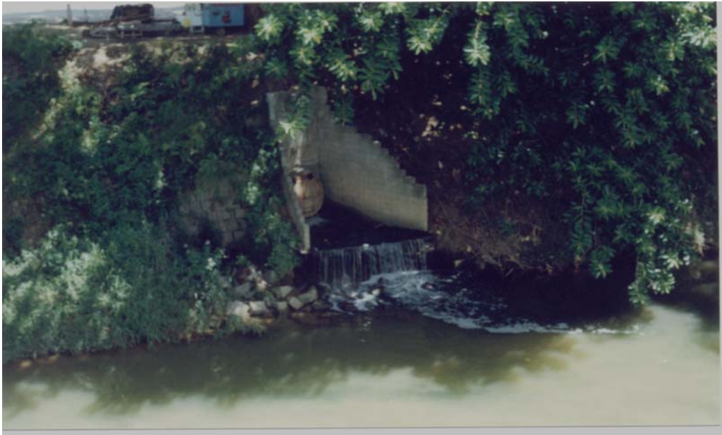
Figura 12 – Lançamento de esgoto doméstico no Rio Tubarão, no centro da Cidade.
