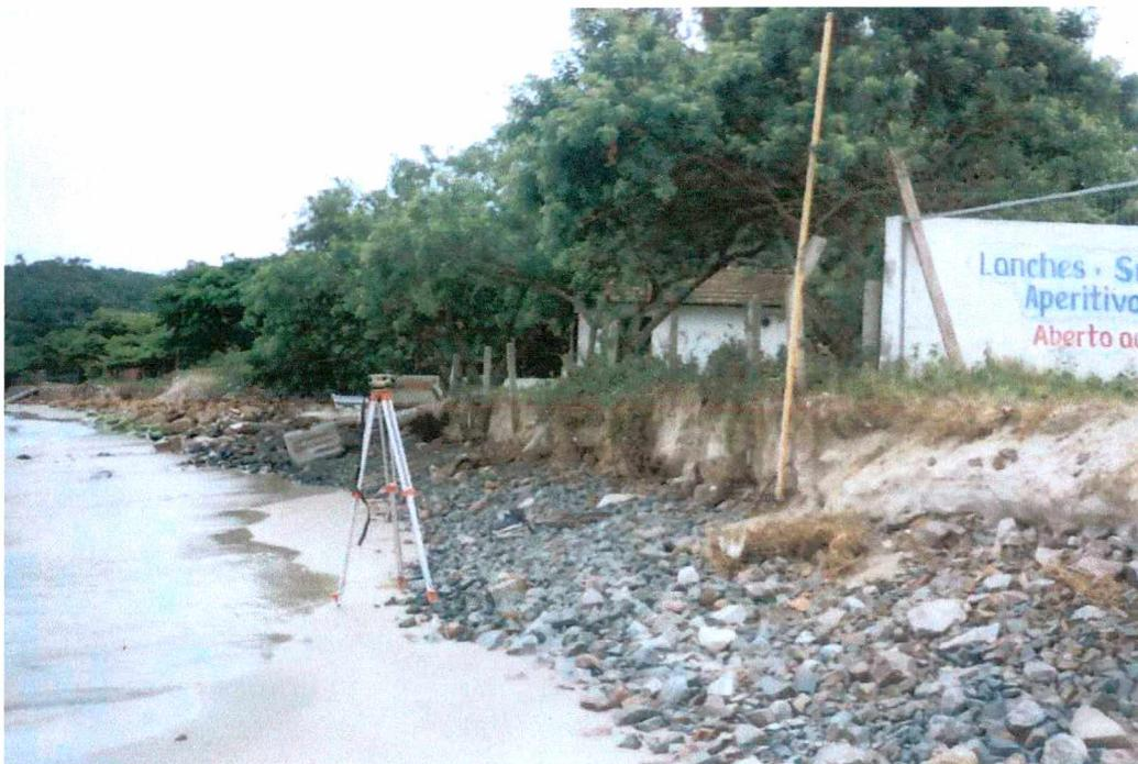
Foto (2). Enrocamento emergencial realizado na tentativa de impedir o recuo da linha de costa no setor Norte (PC 1), em novembro de 1998.
