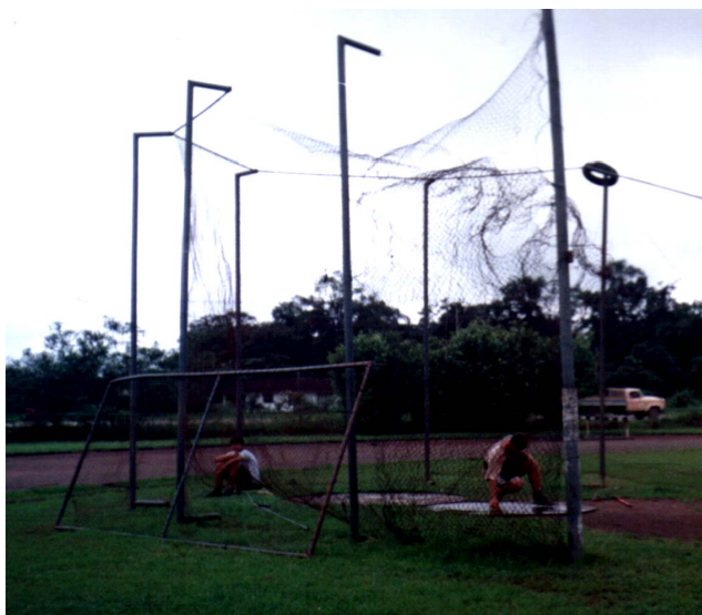
Foto 7 - Gaiola de lançamentos em precário estado de conservação
