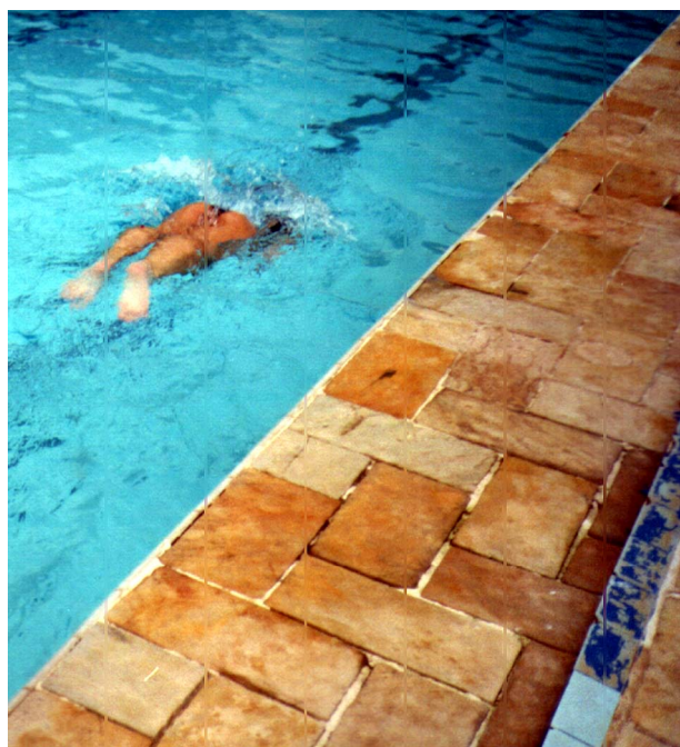
Foto 11 – Estado de conservação da piscina
