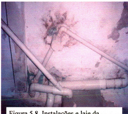
Figura 5.8. Instalações e laje da garagem do condomínio 4
