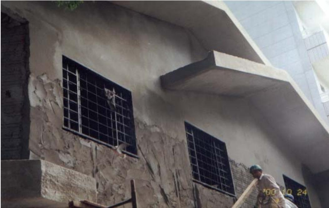
**Figura 7** - Emboço externo, salientando o alinhamento das esquadrias de ferro.
