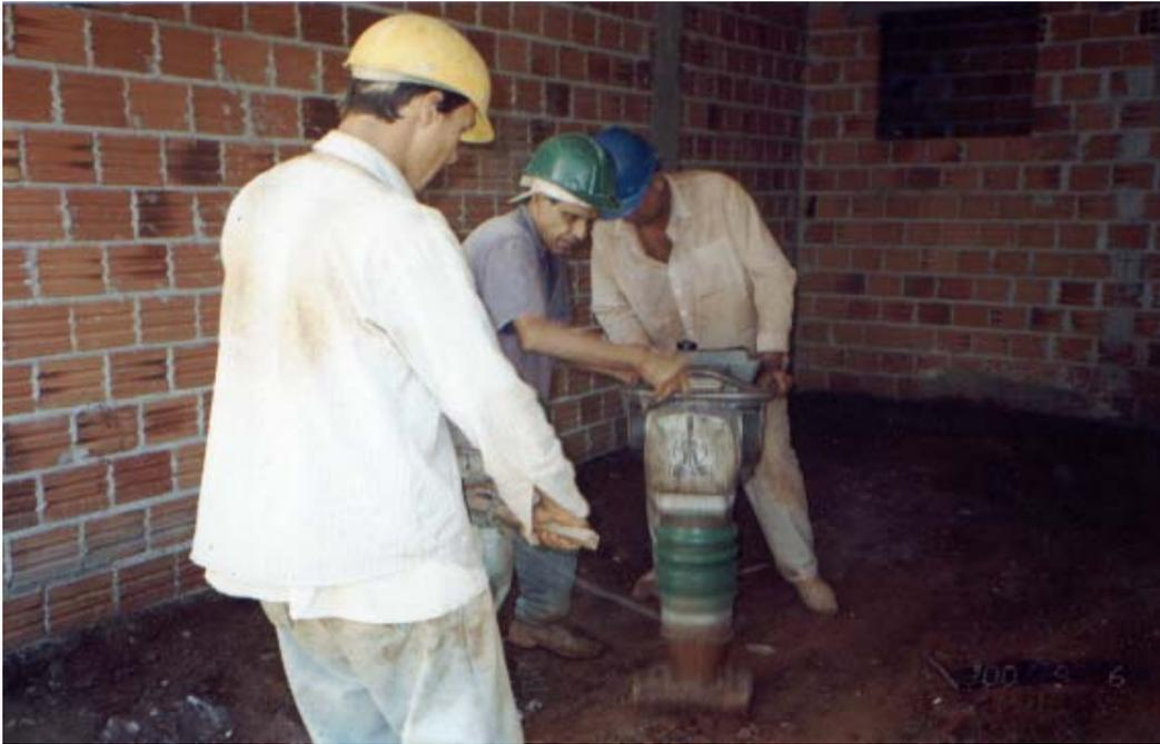
**Figura 5** - Compactação do solo com o sapo mecânico.
