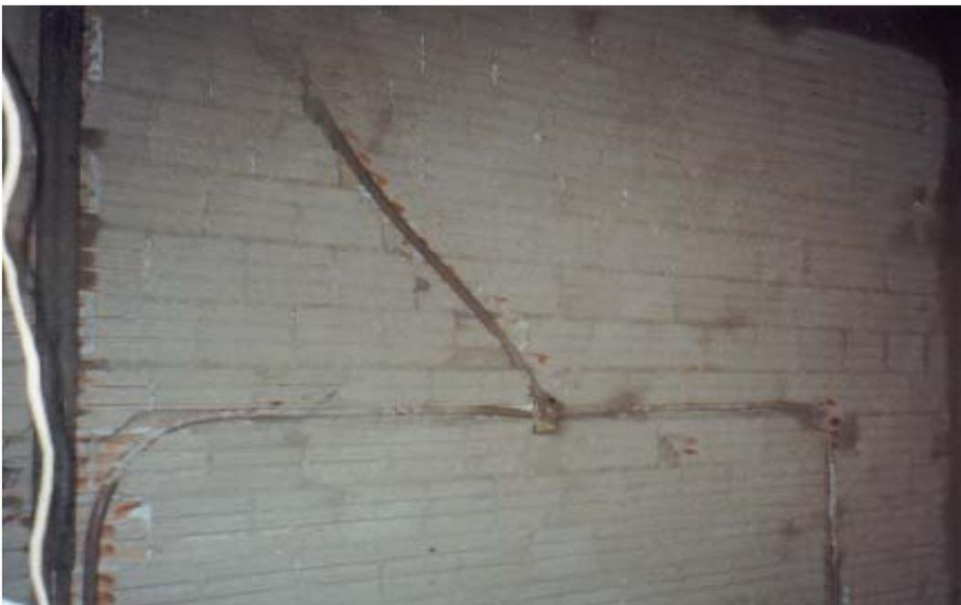
**Figura 4** - Corte de paredes para a colocação das instalações elétricas; após a colocação foi efetuado o chapisco.
