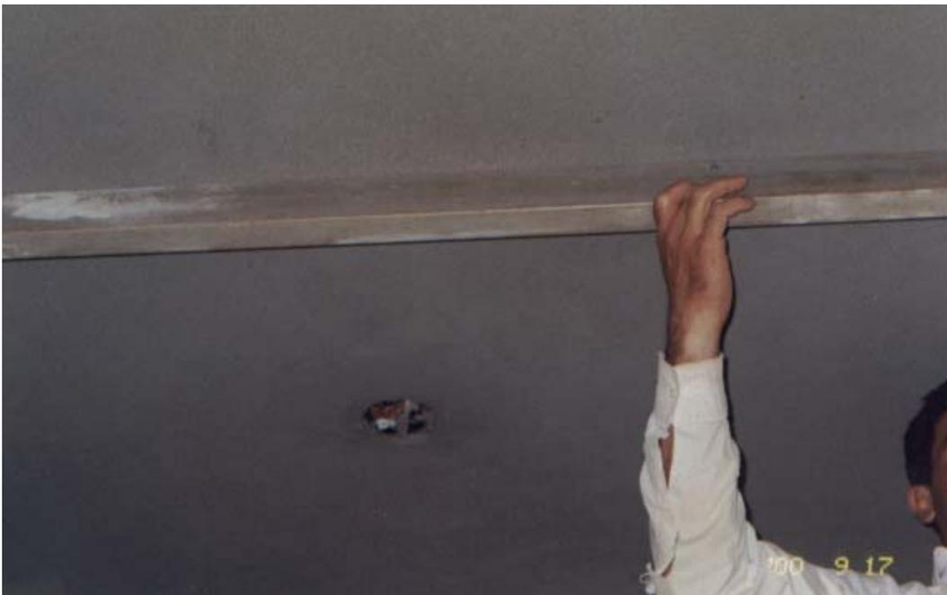
**Figura 6** - Régua de alumínio utilizada para emboço de teto e para conferência do alinhamento do mesmo.
