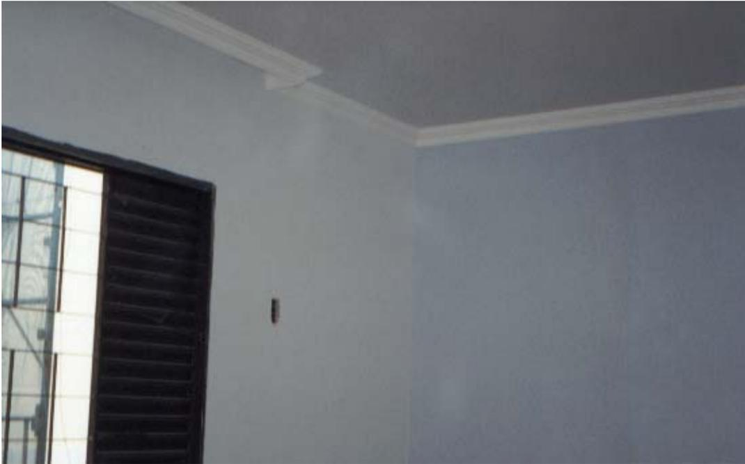
**Figura 09** - Ilustração do quarto da suíte com pintura em duas tonalidades de parede com o teto e moldura em gesso na cor branca.
