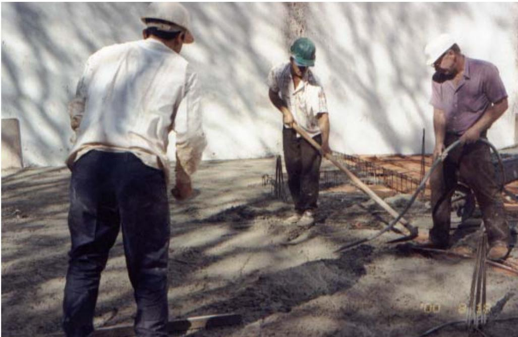
**Figura 2** - Concretagem da laje piso.
