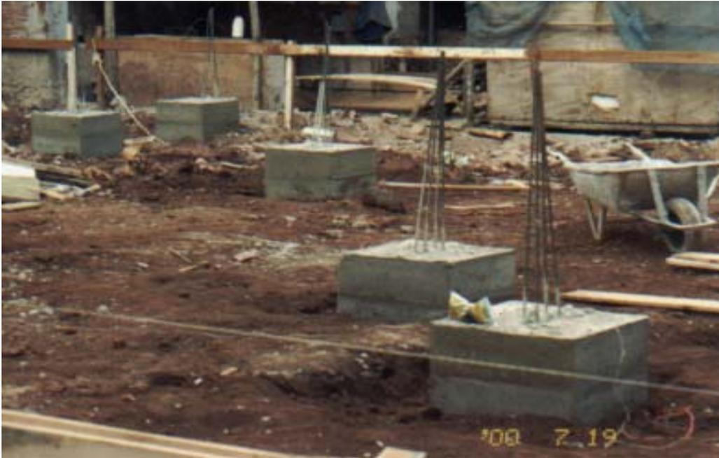
**Figura 1** - Foto dos blocos de fundação após a concretagem.
