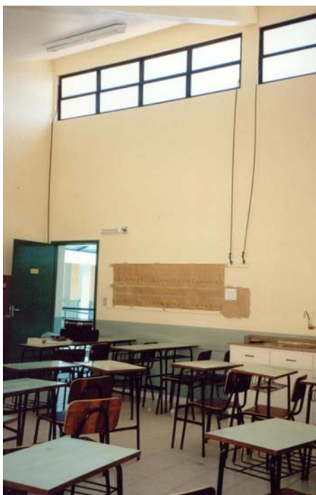
Figura 3-6: Sala 1 - pavimento superior à Leste (Fonte: Arquivo do autor)
