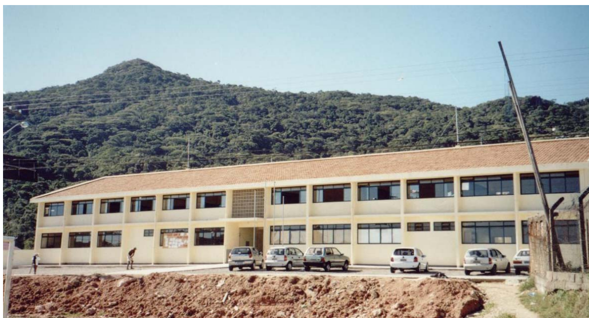
Figura 3-1: Vista frontal externa da Escola Básica Donícia Maria da Costa (Fonte: Arquivo do autor)
