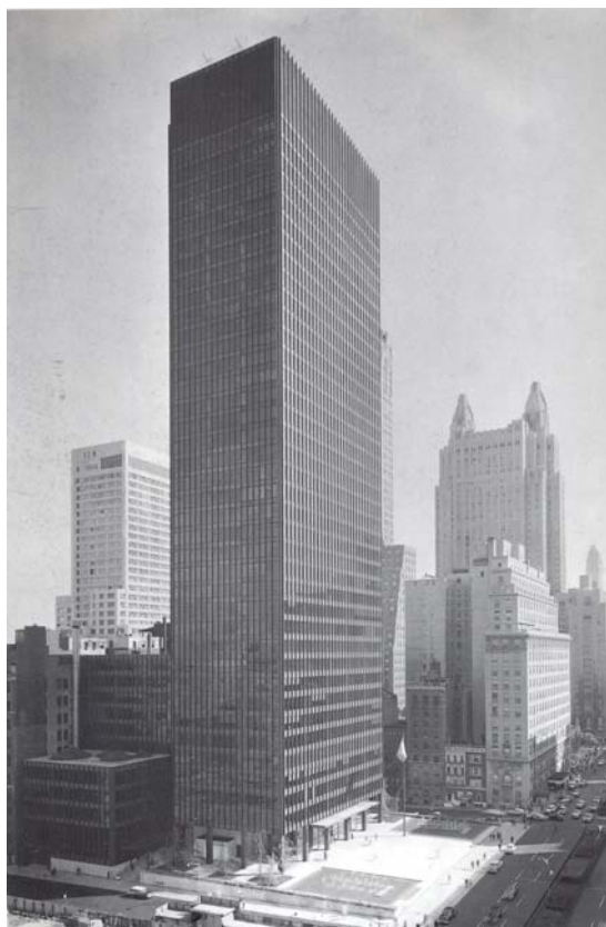
Figura 1-2: Edifício Seagram, Nova Iorque, EUA – Arq. Mies van der Rohe (Fonte: GÖSSEL, 1996)
