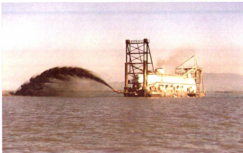
FIGURA 37 - Dragagem de sedimentos do banco de berbigão no baixo das Tipitingas, manguezal do Rio Tavares
