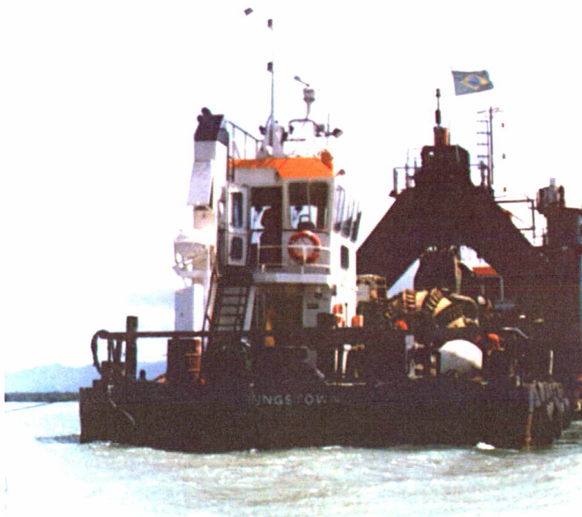
FIGURA 53 - Dragagem hidráulica no Baixo das Tipitingas, manguezal do Rio Tavares, 1996
