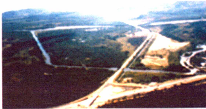
FIGURA 40 - Obra do trevo Canasvieiras - Ingleses e da rodovia SC - 402 sobre o manguezal do Rio Ratoes.
