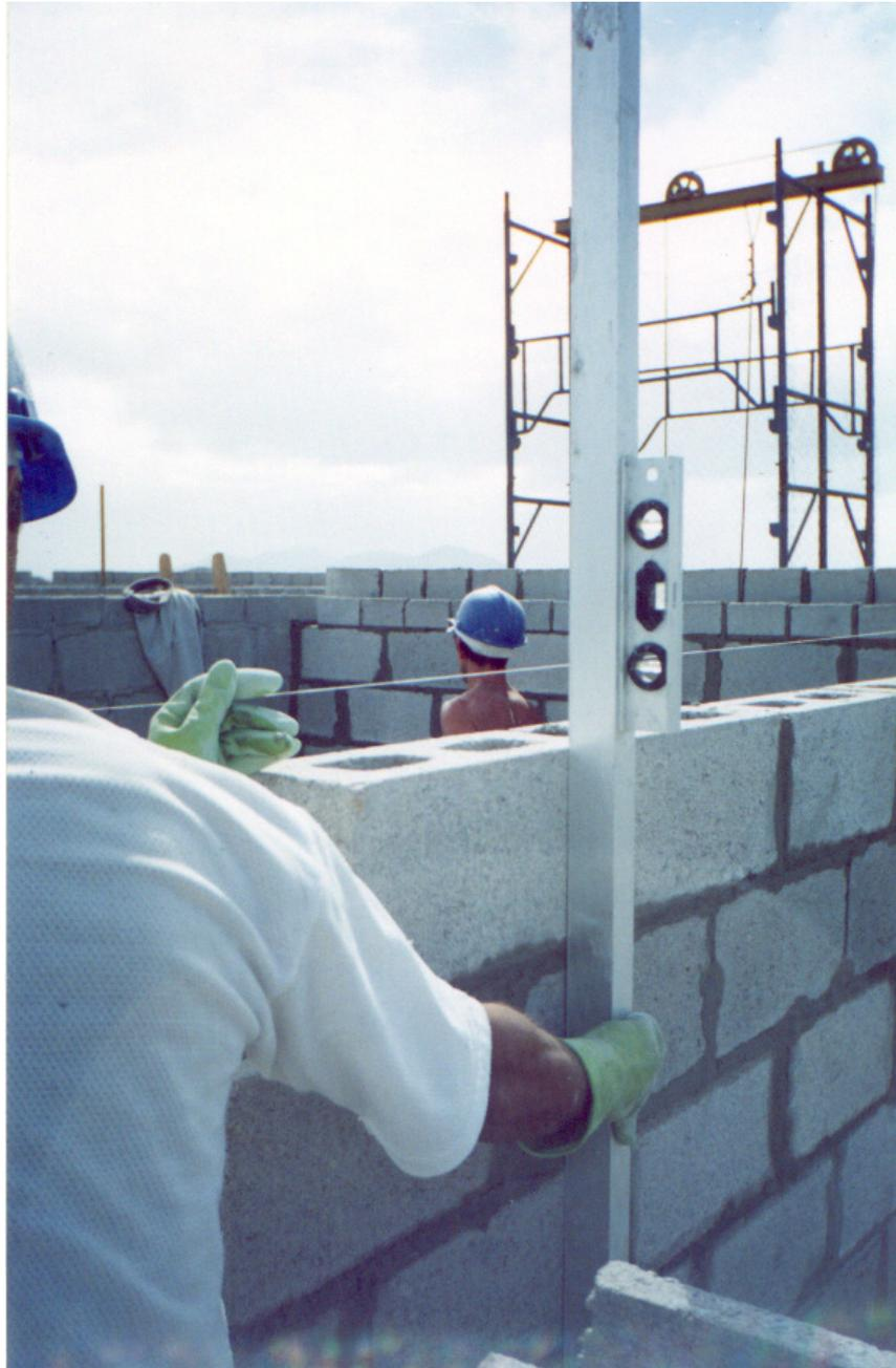
Figura 3.2 – Utilização de régua niveladora para conferir o prumo da parede (Obra 2)
