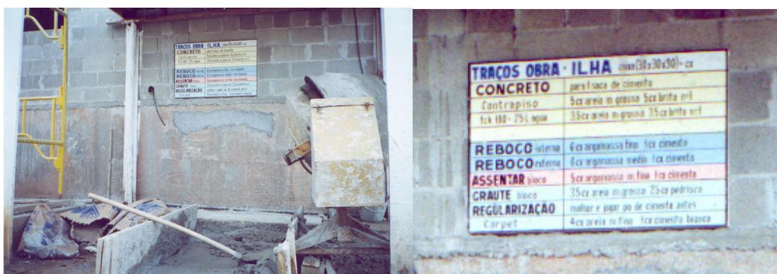
Figura 3.6 – Construtora E (Obra 6): Placa próxima à argamasseira expondo os traços.
