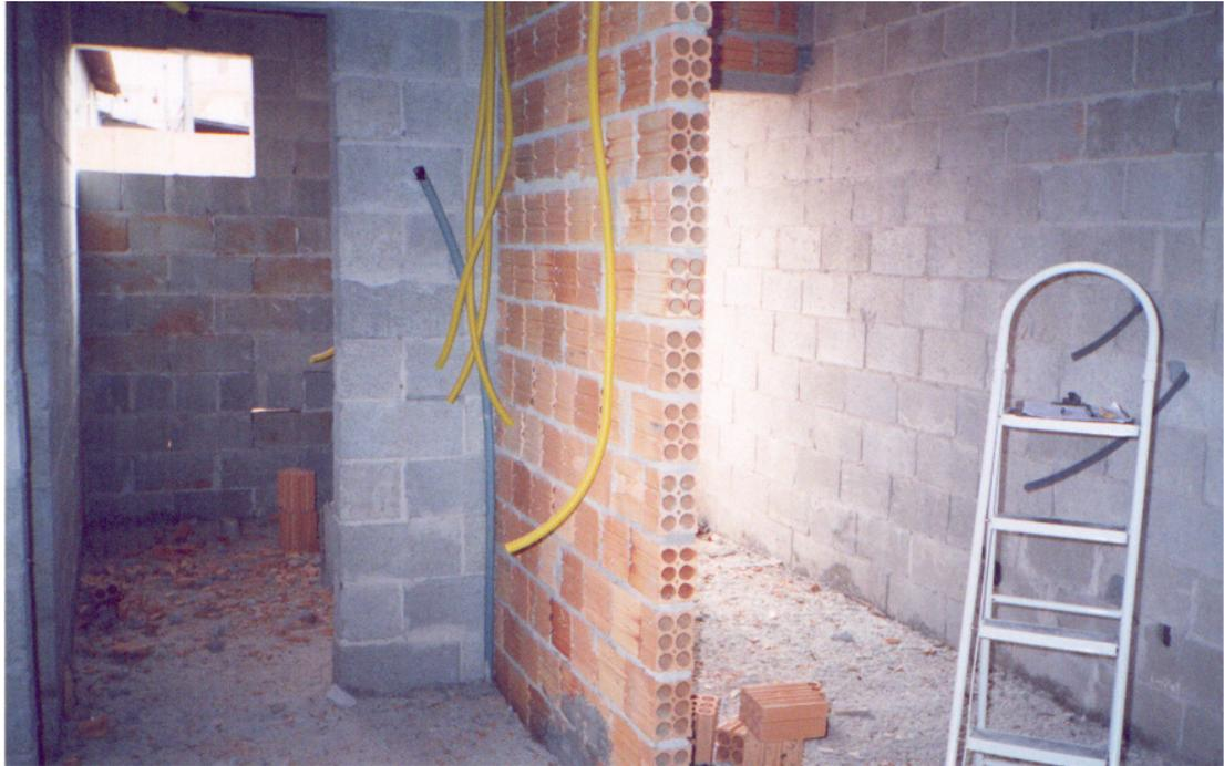
Figura 3.7 – Construtora F (Obra 7): Utilização de tijolos cerâmicos em paredes de vedação.
