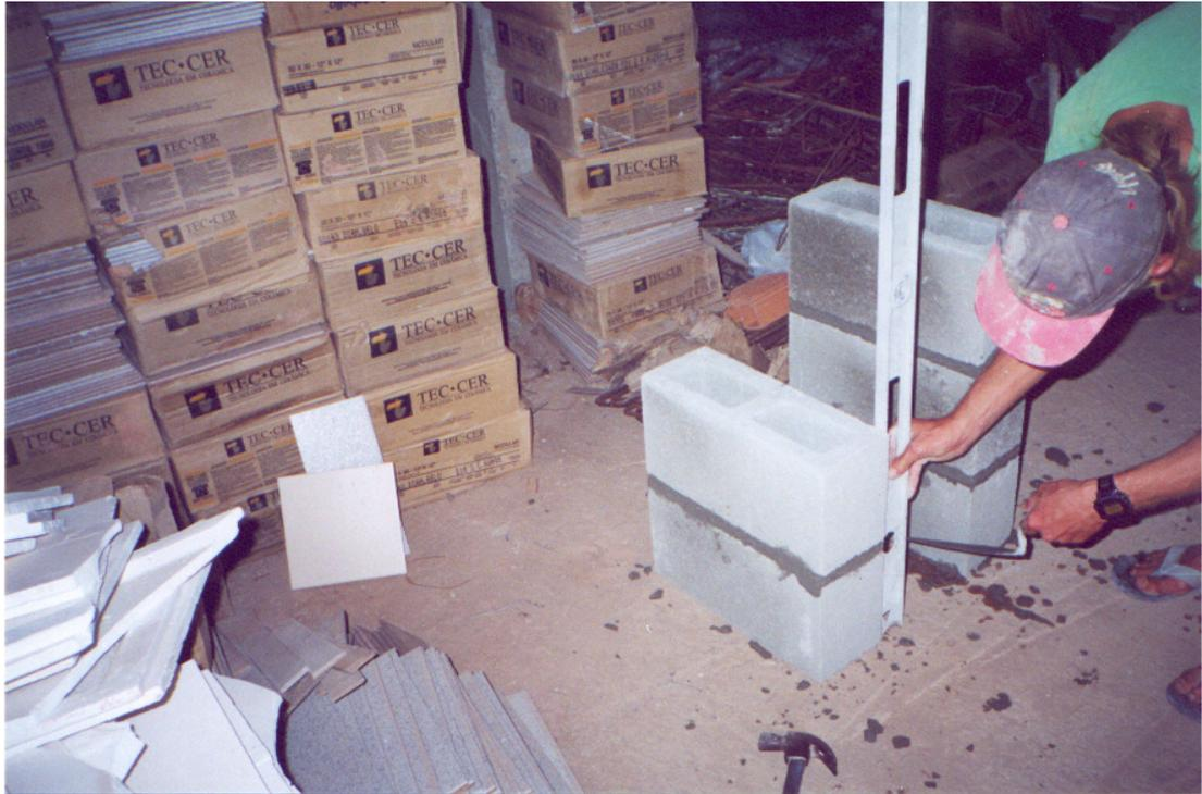
Figura 3.12 – Seqüência de montagem dos prismas de três blocos (Obra 13).
