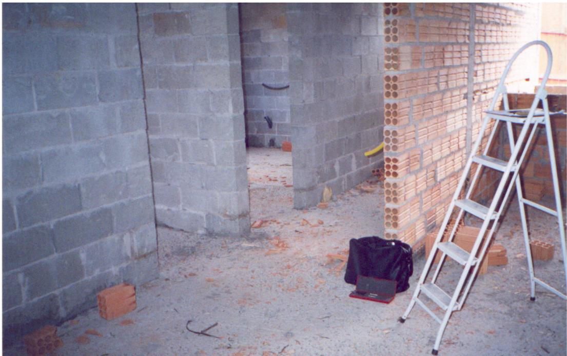
Figura 3.8 – Construtora F (Obra 7): Utilização de tijolos cerâmicos em paredes de vedação.
