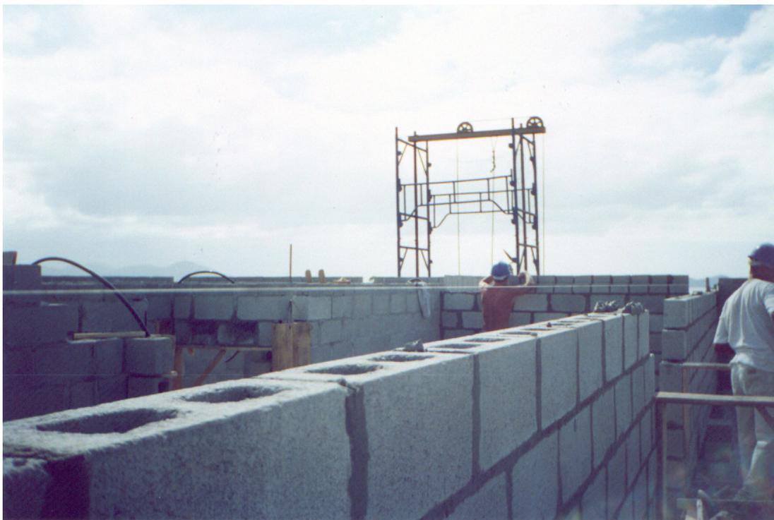
Figura 3.3 – Utilização de linha de *nylon* para alinhar e nivelar as fiadas (Obra 2).
