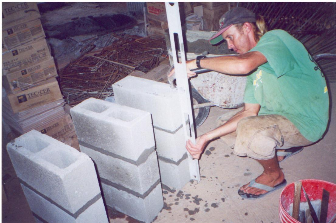
Figura 3.13 – Pedreiro apumando os prismas com régua niveladora (Obra 13).
