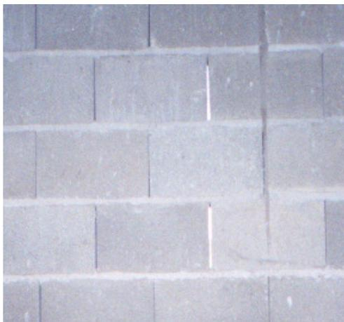
Figura 3.4 – Construtora C (Obra 4): Detalhe das juntas verticais sem argamassa.
