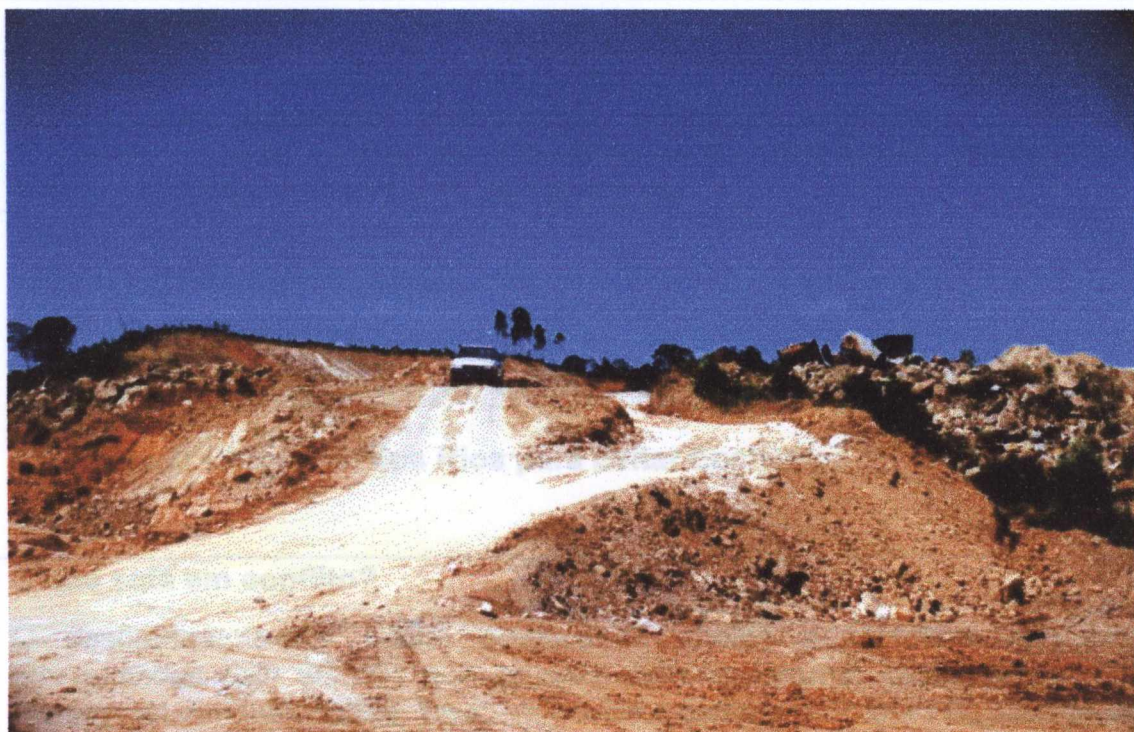
Foto 14: Abertura de caixa de empréstimo na região de Ratonos para construção civil.
