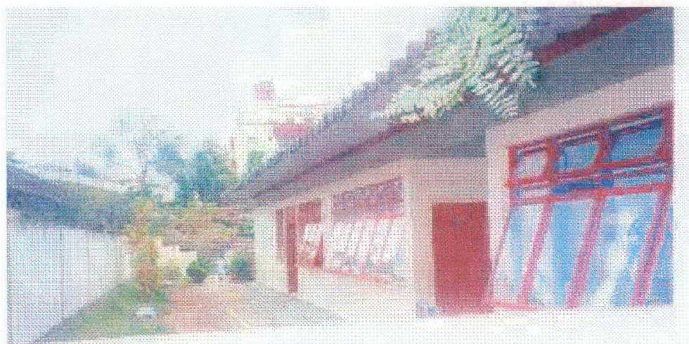
Vista da Creche, do parque para a entrada (fotografia 3)
