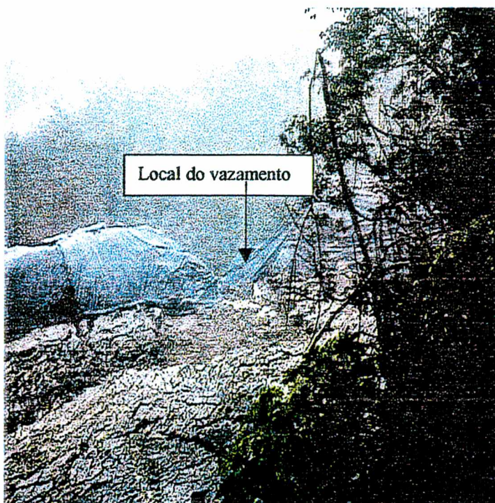
FOTO 03: Ao fundo destaca-se o ponto onde ocorreu o rompimento da borda do tanque.
