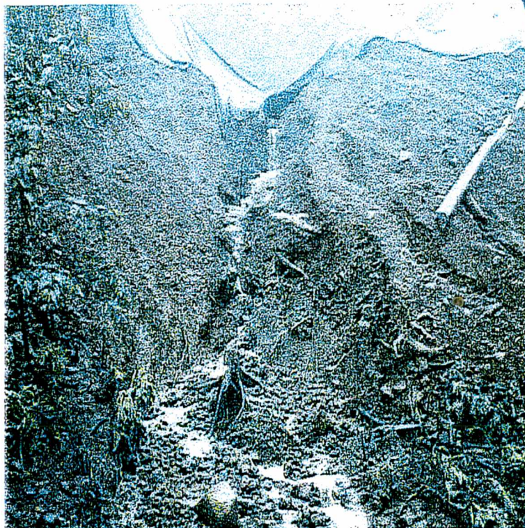
FOTO 01: Na parte superior da imagem acima, verifica-se o rompimento da borda de contenção do tanque destinado ao depósito de detritos industriais da Empresa SADIA S/A.
