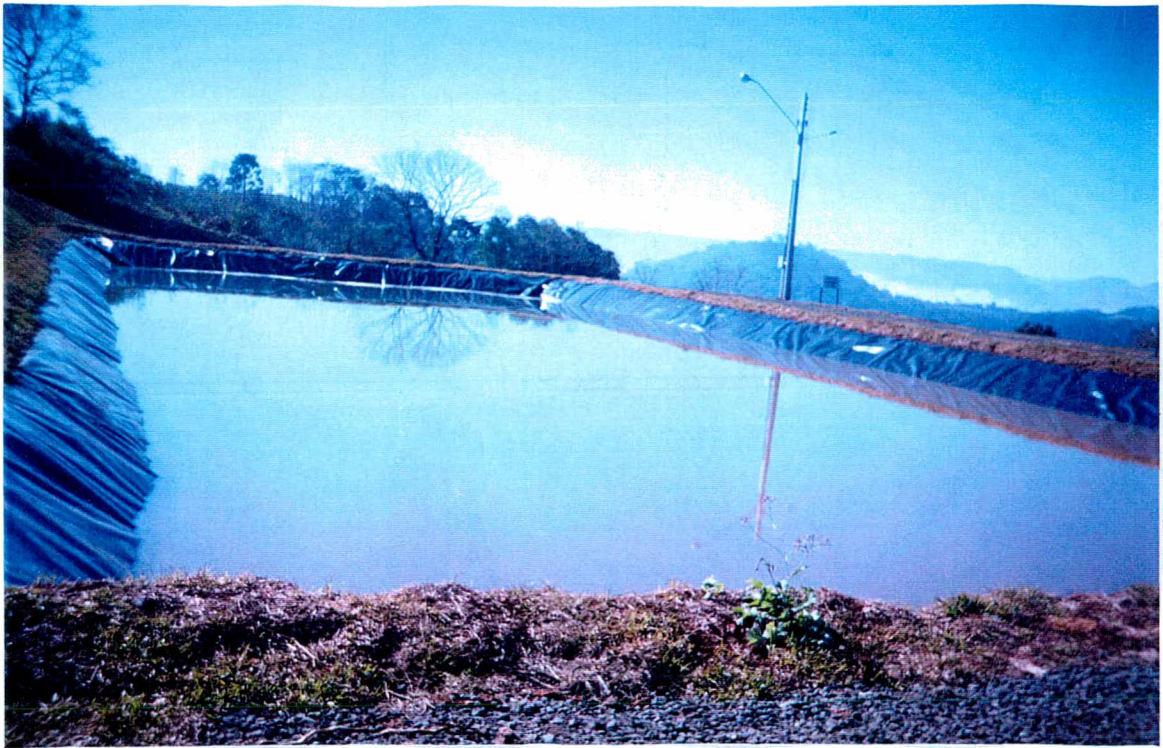
Foto 7 - Um dos Tanques de decantação do aterro sanitário de chapecó, local onde existia nascente que formava banhado (Foto de José Ortiz, julho de 2000).
