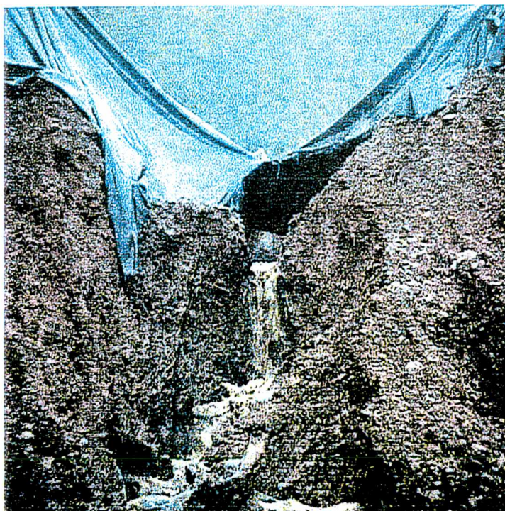
FOTO 05: Vista frontal do ponto onde ocorreu o vazamento.
