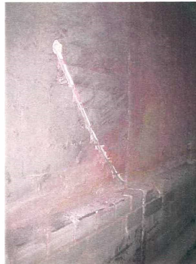
Figura 5.4 – Fotografias mostrando a instalação dos termopares para medição da temperatura do piso e dos gases sob as vagonetas.
