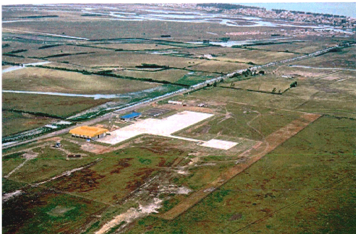
Figura 4.4 : Fotografia aérea do Heliporto de São Tomé em Campos, RJ.
