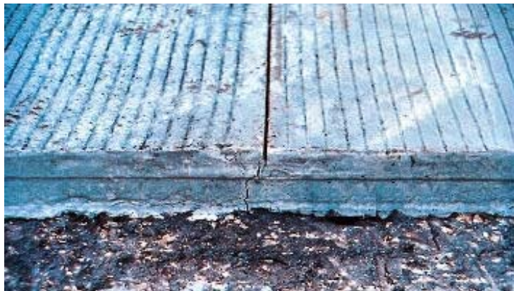
FIGURA 3 – Ultra Thin Whitetopping (28)
