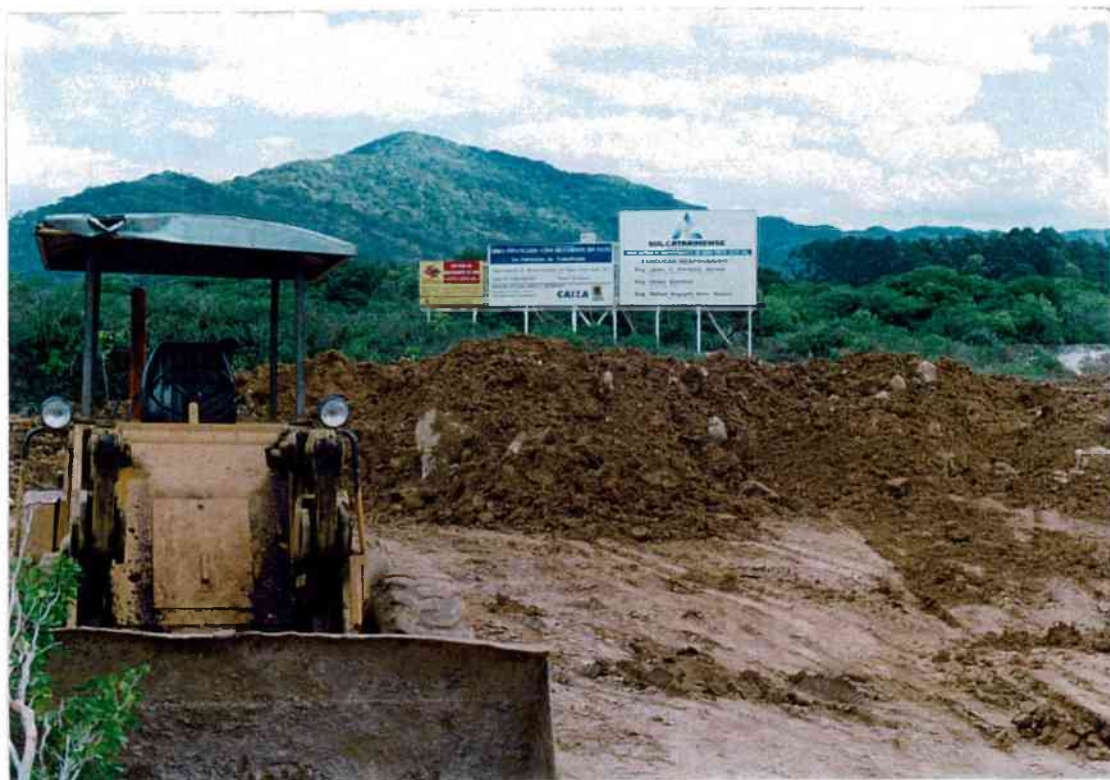
Fotografia12: Canteiro de obras da ETA do Projeto Costa Leste-Sul
