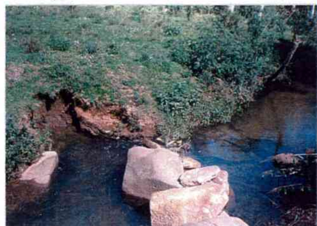
07. Erosão das margens do Rio Ribeirão Grande
