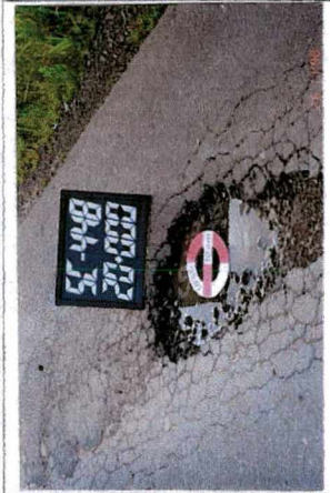
Foto 28 Painela e trinca tipo "couro de jacaré" Classe 3 Lado Direito
