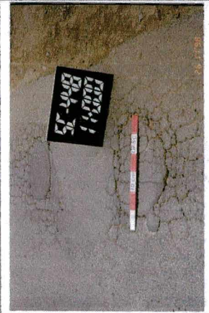
Foto 1 Trinca tipo "couro de jacaré" Classe 3 e afundamento de Trilha de Roda e Trilha de Roda Externa-Lado Esquerdo
