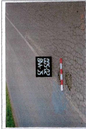
Foto 26 Trinca tipo "couro de jacaré" Classe 3 Lado Direito
