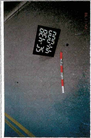
Foto 4 - 144+000* Trinca tipo "couro de jacaré" Classe 1 Lado Direito
