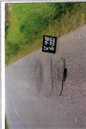
Foto 19 Remendos e trinca tipo "couro de jacaré" Classe 3 Lado Direito
