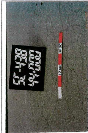
Foto 1 - km 137+000* Trinca Interligada Classe 3 e Painela Lado Esquerdo
