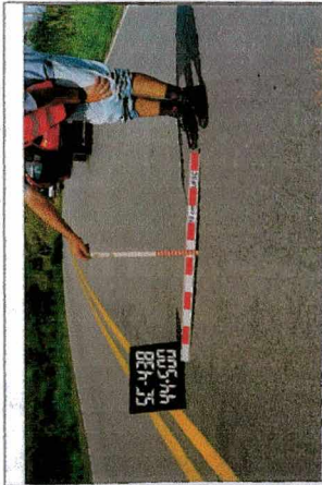
Foto 2 - km 139+000* Trinca tipo "couro de jacaré" Classe 1 Lado Direito
