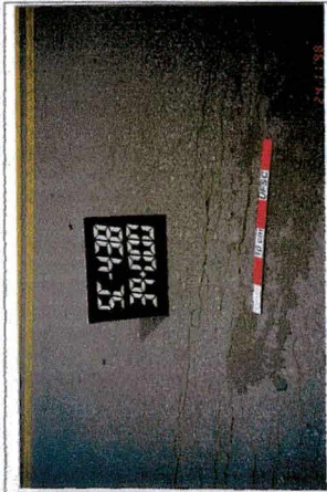
Foto 2 - km 139+000* Trinca tipo "couro de jacaré" Classe 1 Lado Direito
