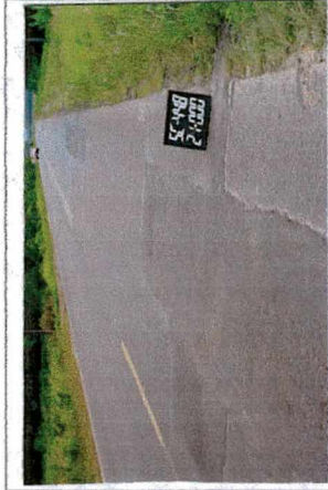
Foto 27 Painela e trinca tipo "couro de jacaré" Classe 3 Lado Esquerdo
