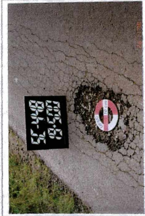
Foto 27 Painela e trinca tipo "couro de jacaré" Classe 3 Lado Esquerdo
