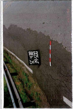
Foto 3 - 139+500* Remendo Lado Esquerdo
