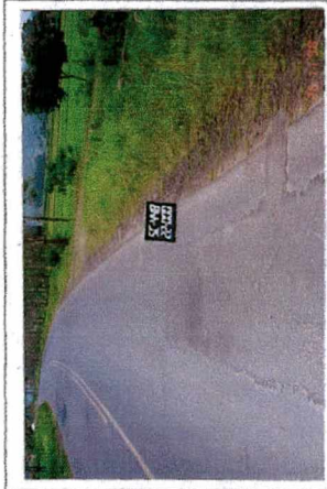
Foto 28 Painela e trinca tipo "couro de jacaré" Classe 3 Lado Direito
