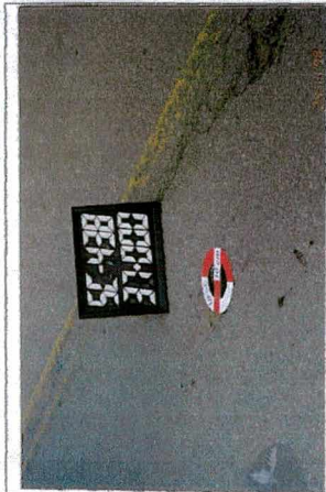
Foto 1 - km 137+000* Trinca Interligada Classe 3 e Painela Lado Esquerdo
