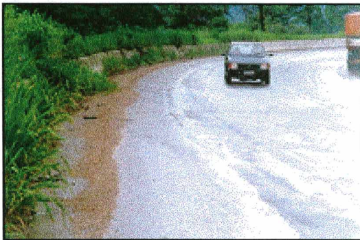
Fig.8.1.3.9. Elementos Exógenos Indesejáveis na Rodagem: Solo, Vegetação e Óleo.
