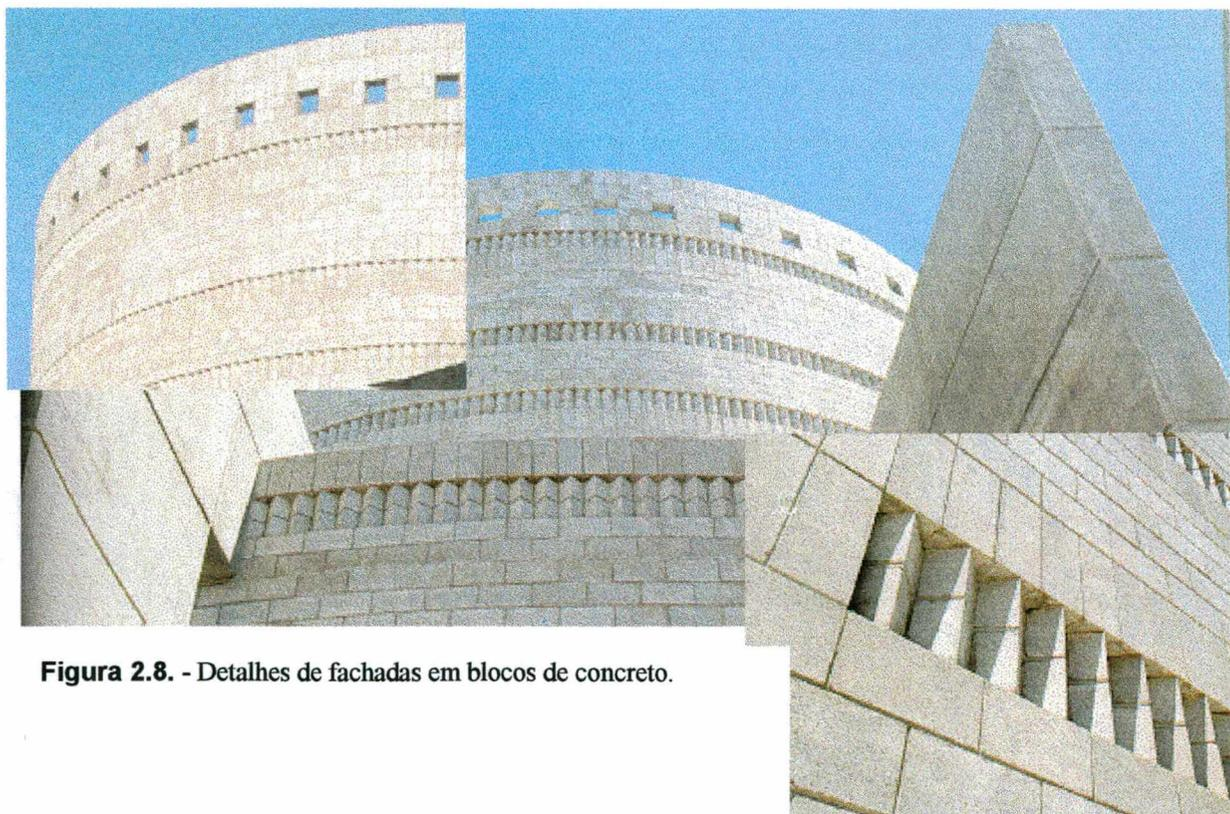
**Figura 2.8.** - Detalhes de fachadas em blocos de concreto.
