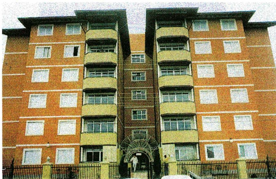
**Figura 5.31.** - Sacadas em edifício construído em alvenaria estrutural com blocos cerâmicos.
