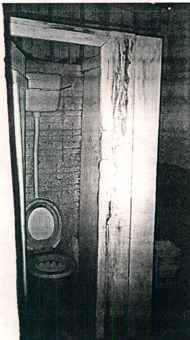
WC (Canteiro A - Empresa Gama)
