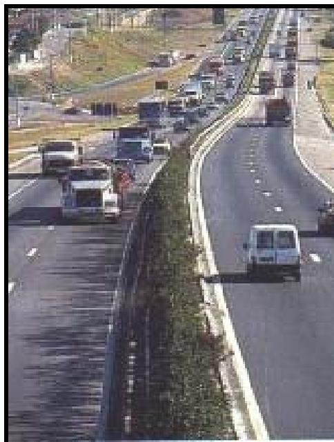
**FIGURA 4.5** Pista dupla com barreira de concreto, e cerca antiofuscente
