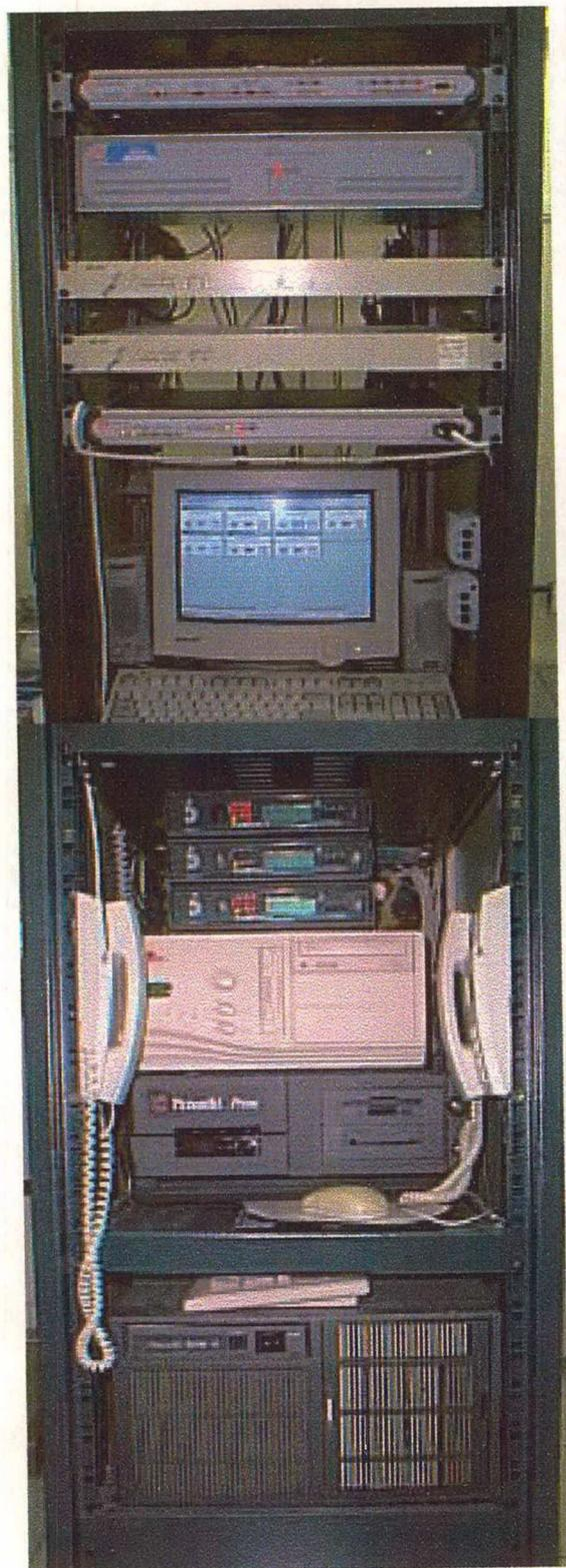
**OPTIMUX RAD 4 E 1**- Estabelece Links de 2 Megabits em cima do enlace de fibra ótica entre NPD e LED.
