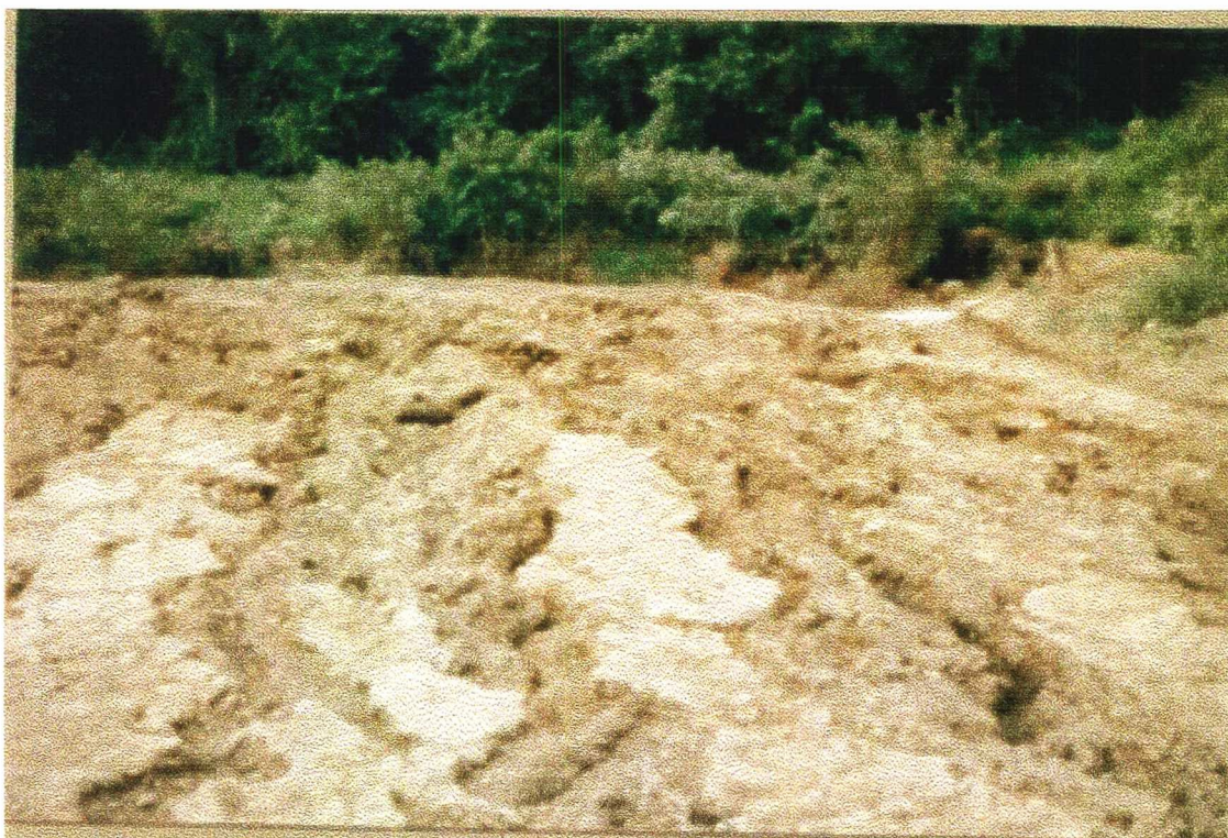
Fig. 4.03. Lagoa de estabilização anaeróbia assoreada principalmente por estrume
