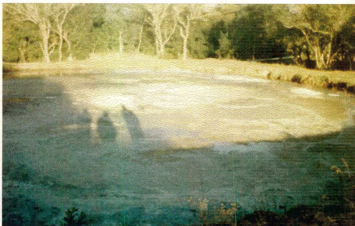
Fig. 1.03. Aspecto visual de um sistema de tratamento com problema de concepção.
