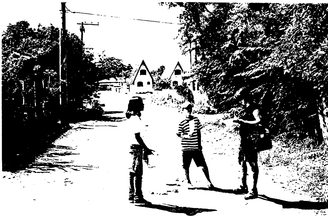
Foto 15 – Falta de calçamento
