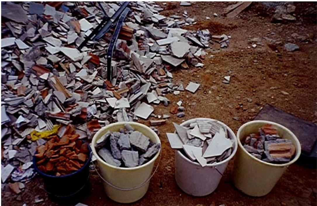
FIGURA 4.4 - Separação do resíduo da construção civil em recipientes por componentes.
