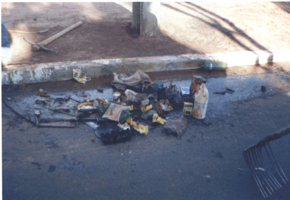
Fonte: Acervo da Prefeitura Municipal de Umuarama Figura 28 – Lixo retirado de galeria pluvial
