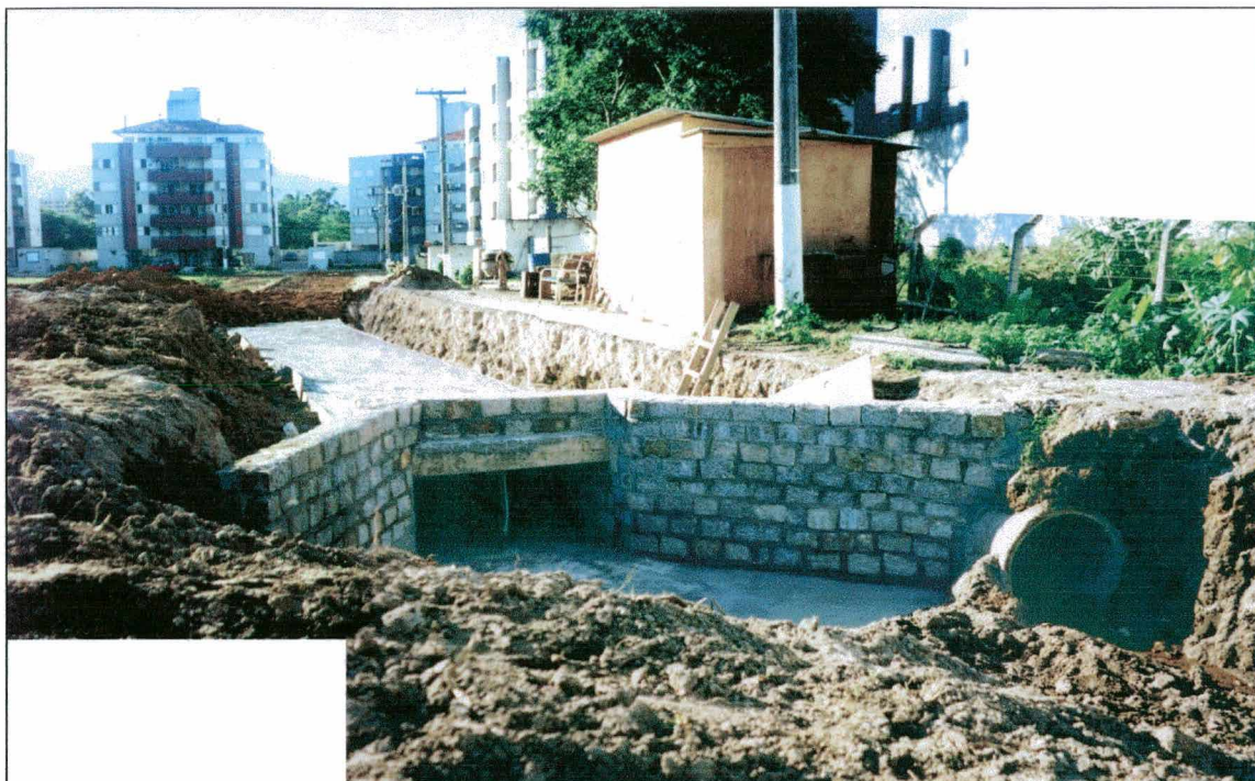
Figura ap.I.5 – Fotografias mostrando o trabalho de ampliação da rede de drenagem. Ano: 2001.
