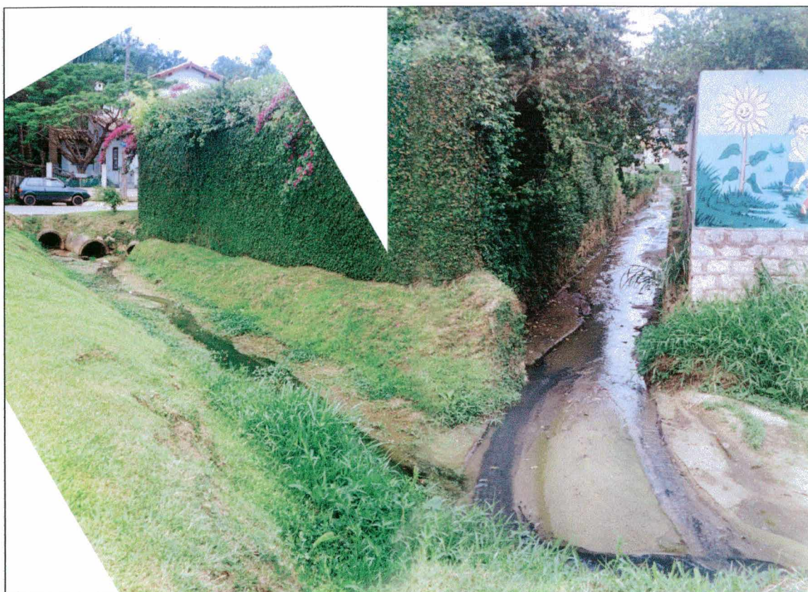
Figura ap.I.8 – Fotos onde aparecem: saídas das canalizações dos rios e formas de ocupação das margens dos mesmos. Ano: 2001.
