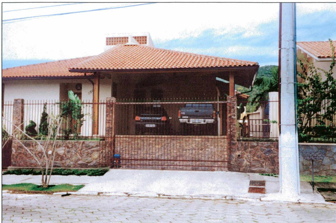
Figura ap.I.10 – Fotografia mostrando lote aterrado em mais de um metro em relação ao nível da rua. Ano: 2001.
