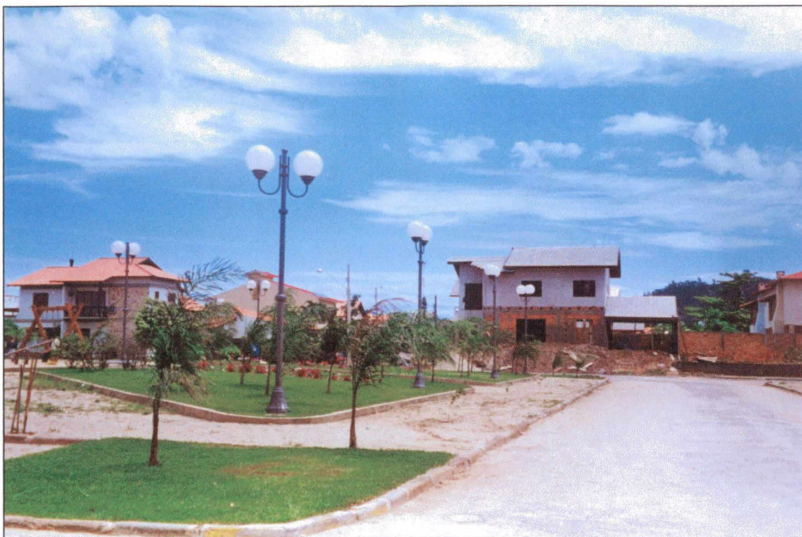
Figura ap.I.9 – Fotografia onde aparece areia sobre o passeio e aterro sem proteção na construção ao fundo. Em ambos os casos na ocorrência de chuva estes materiais tendem a se deslocar para a rede de drenagem. Ano: 2001.
