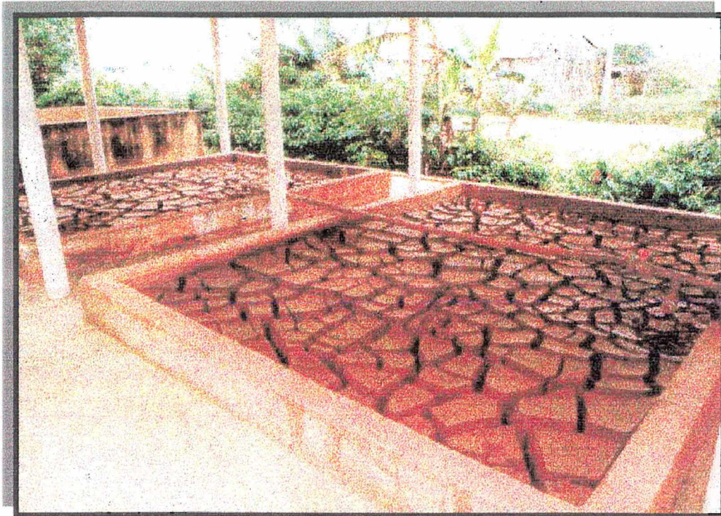
FIGURA 4 – DECANTAÇÃO E SECAGEM DO LODO - RESÍDUO 1
