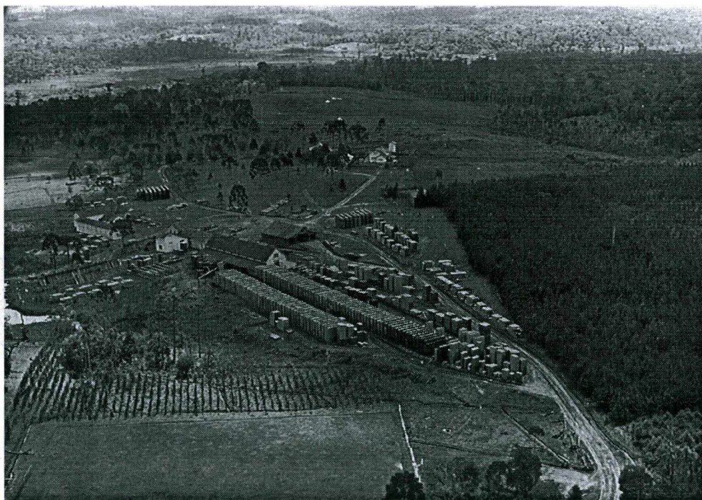
Figura 5. Vista da madeireira INDUMA Ltda.
