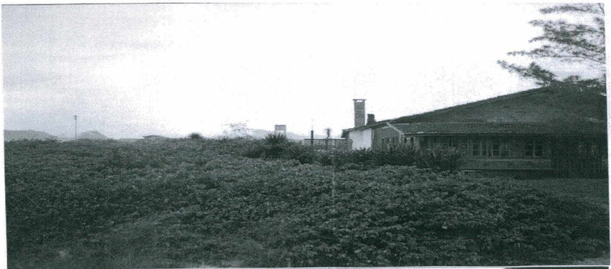
Figura 17: Vista da demolição parcial da antiga construção localizada sobre vegetação fixadora de dunas na Praia do Campeche, Florianópolis, SC (09.11.98).
