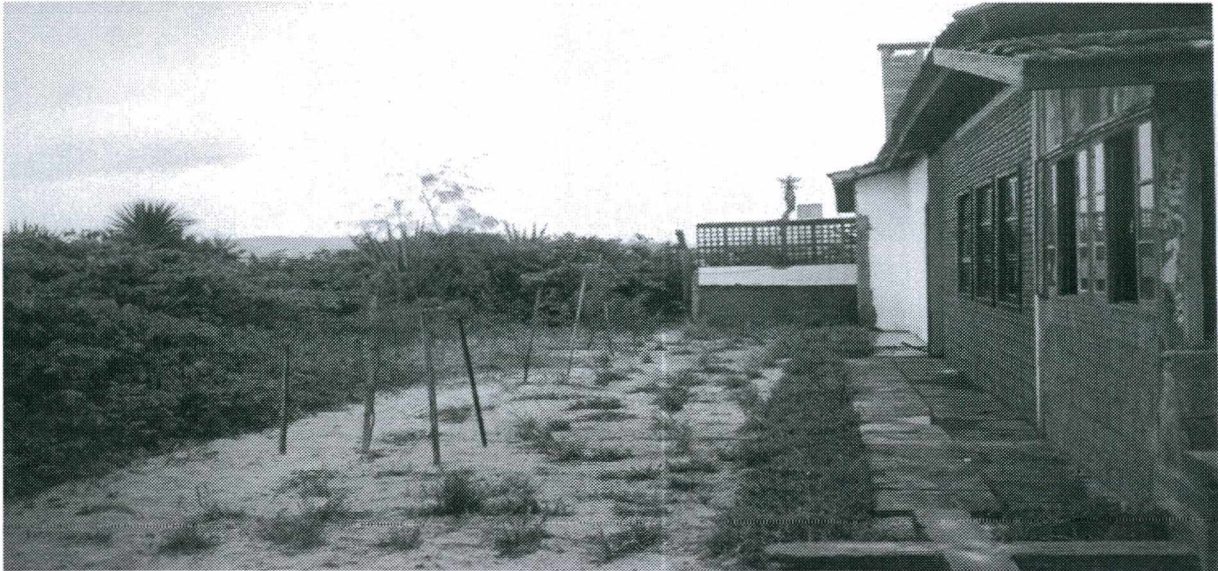
Figura 18: Vista da demolição parcial da antiga construção localizada sobre vegetação fixadora de dunas na Praia do Campeche, Florianópolis, SC (09.11.98).
