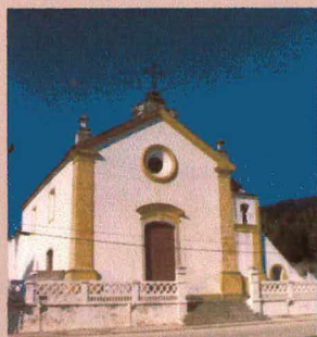
Igreja N.Sra. das Necessidades Sto. Antônio
