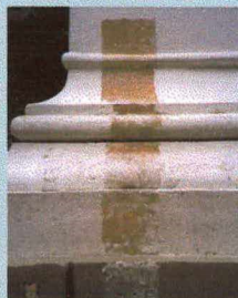
- Esta prospecção mostra as camadas de rebocos que foram feitas no Atrio-cruzmeiro, desde a construção da igreja aos dias de hoje.
