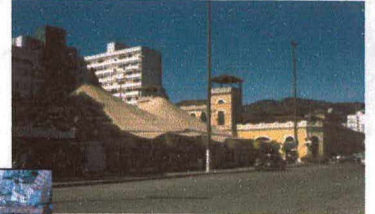
Vista do Camelódromo com cobertura em lona
