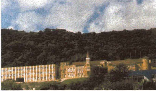
Conjunto arquitetônico Hospital de Caridade
