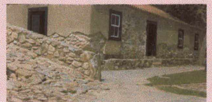
Forte São José após o restauro Detalhe da diferenciação entre as estruturas parietais originais e aquelas reconstituídas
