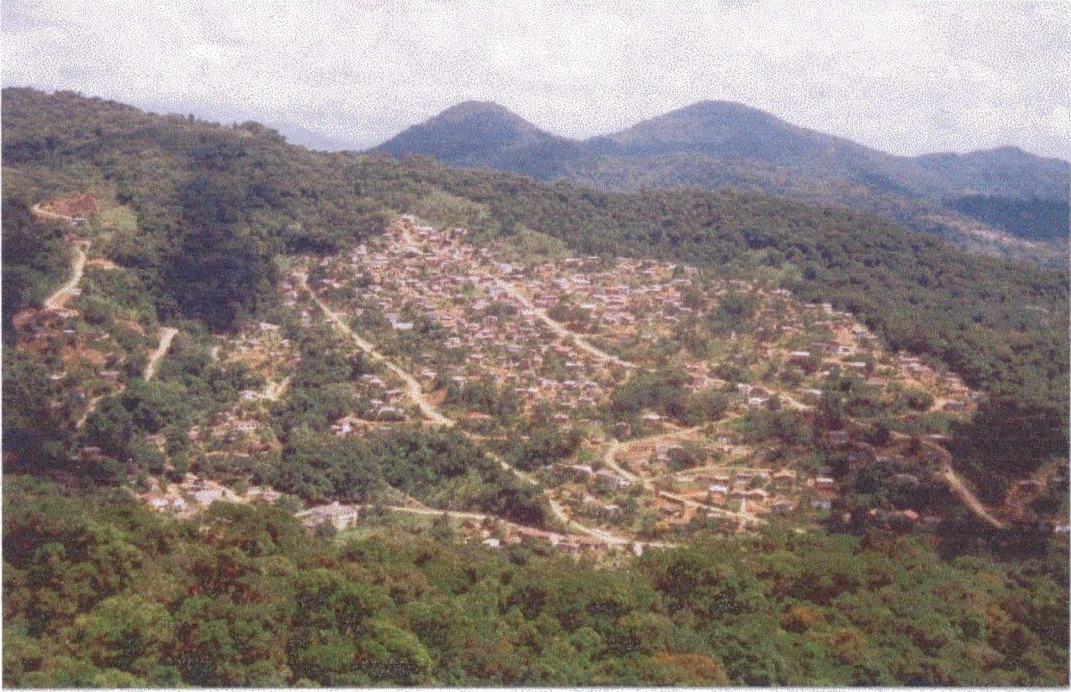
IMAGEM 3: Implantação inadequada do loteamento irregular D, Edith.
