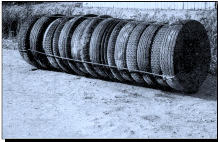
Figura 2.4 - Emprego de pneus em obras de drenagem
