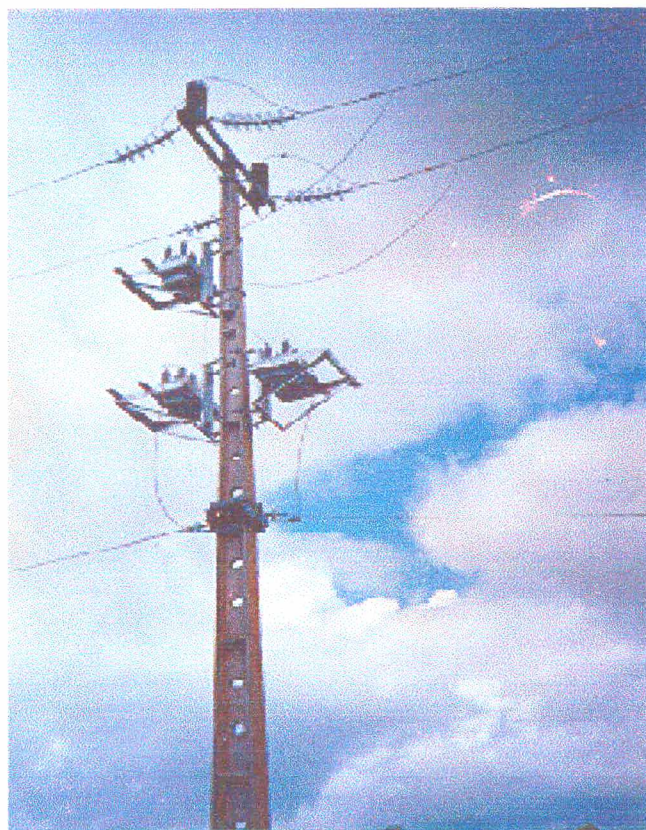
Figura 3.9- Instalação de capacitores de compensação, equalização e pára-raios no Sistema PRE de Rondônia.
