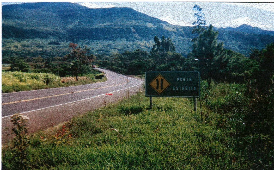
Figura V.5.1-VIII: Ponte Sobre o Rio Maquiné - Localização no Final da Curva.
