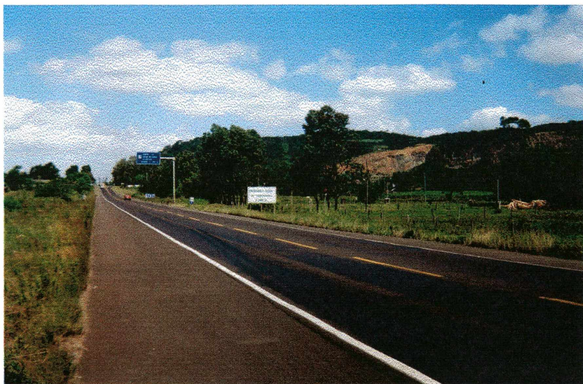
Figura V.5.1-VII: Áreas Escorregadias na Pista - Região do Morro Alto
